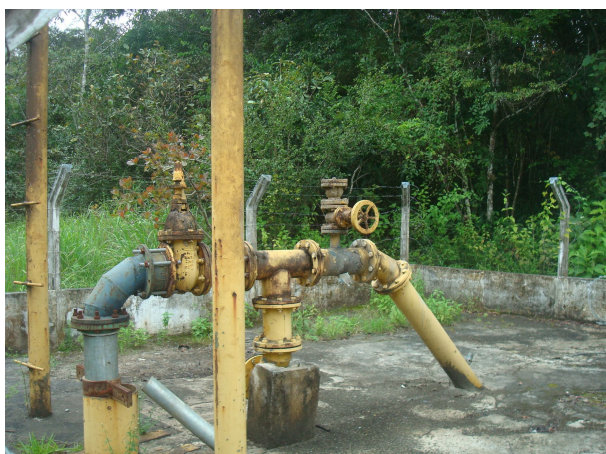
Figura 17: Poço de captação de água pela DESO na Flonai
