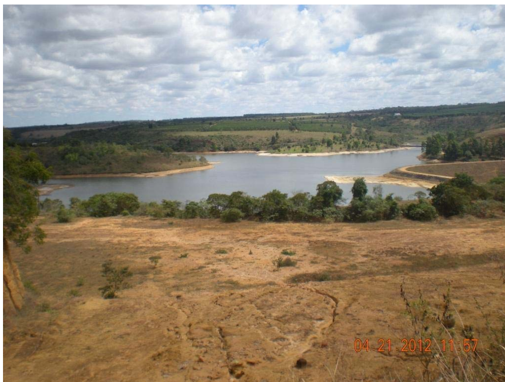
Foto 14: Barragem da Água Fria II, município de Barra do Choça - Bahia
