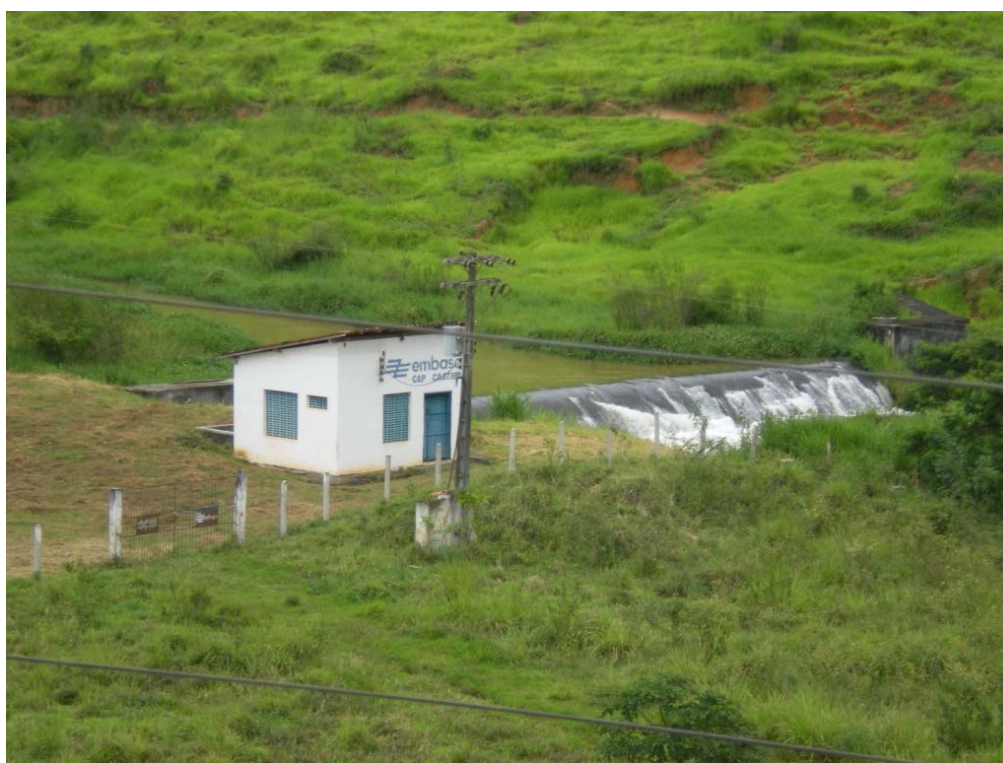
Foto 17: Captação de água para abastecimento da cidade de Caatiba
