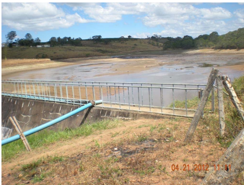
Foto 13: Barragem da Água Fria I, município de Barra do Choça - Bahia
