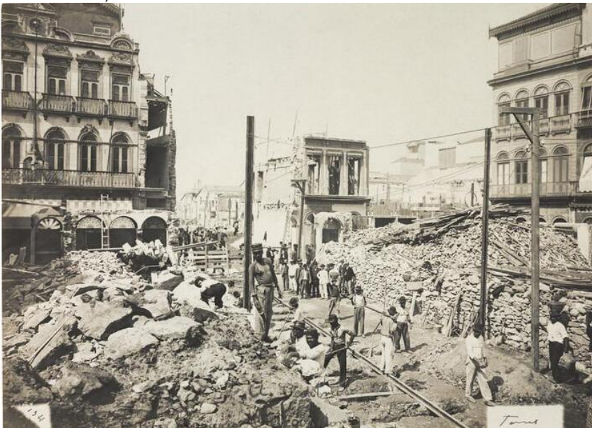
Figura 4: Demolições entre as ruas do Rosário e Ouvidor, avenida Central, atual avenida Rio Branco, Rio de Janeiro, 1904.
