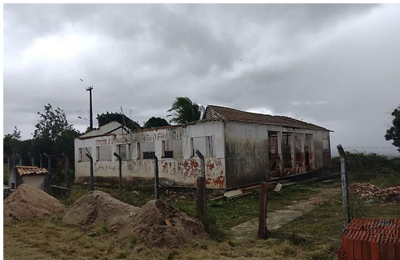
Figura 07 – Centro de Triagem da CORD antes da reforma
