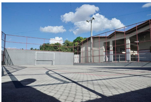
Figura II: Foto da quadra de esportes do colégio. Fonte: Imagem registrada pelas autoras
