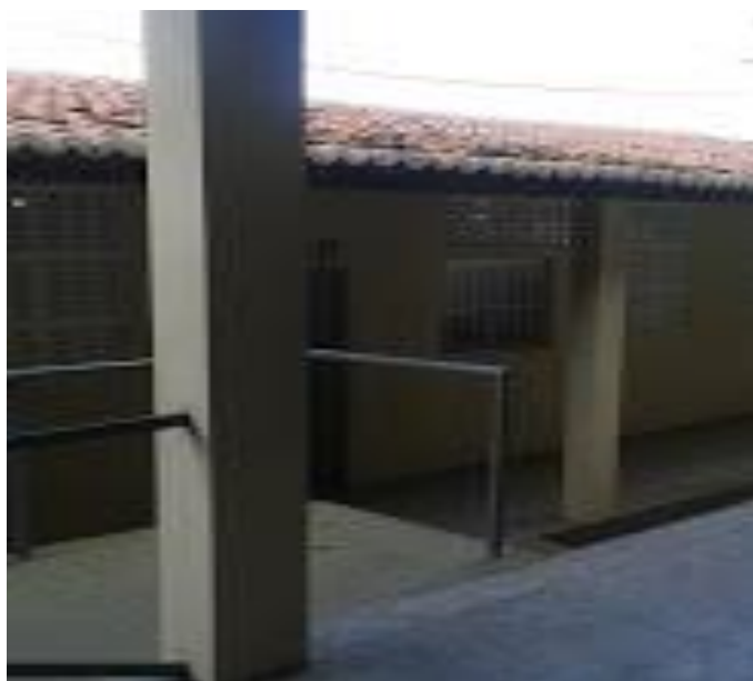
Foto 4: Rampas de acesso na escola.
