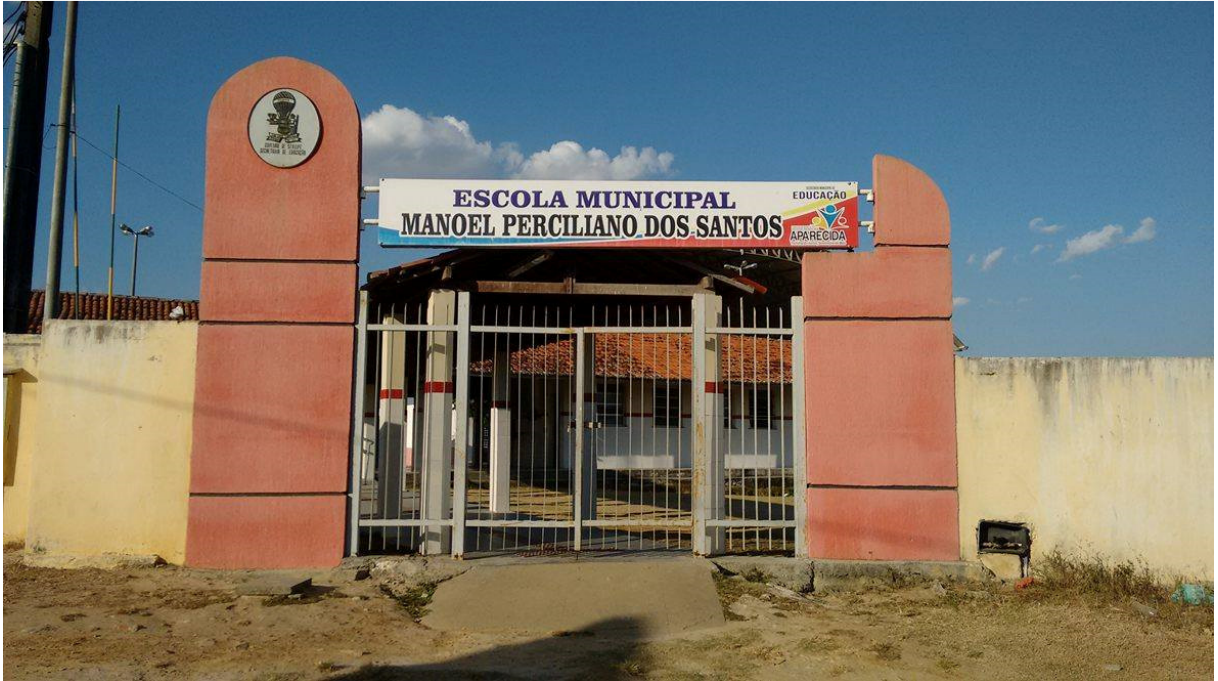
( Fachada principal e entrada da escola)
