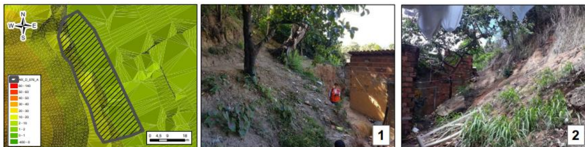
Figura 8 - Fotos e Elementos Informativos da na área de risco 2
