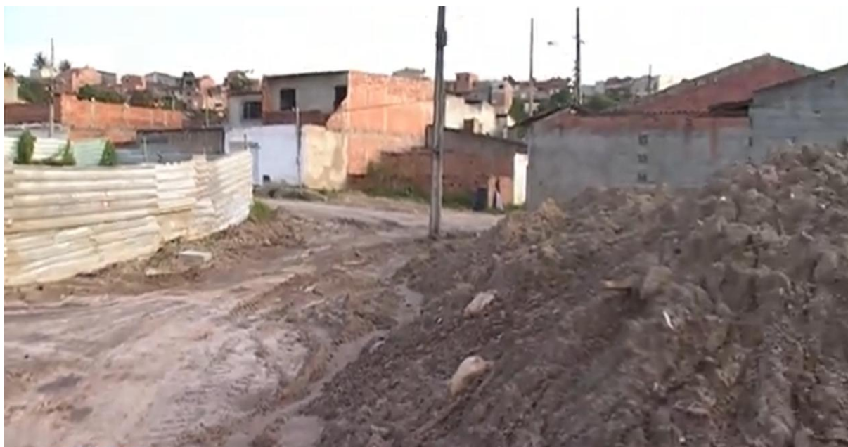
Figura 3 - Obras paradas no Loteamento Copacabana, Porto Dantas
