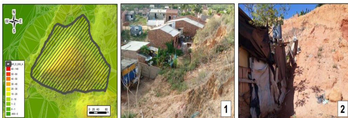
Figura 7 - Fotos e Elementos Informativos da na área de risco 1
