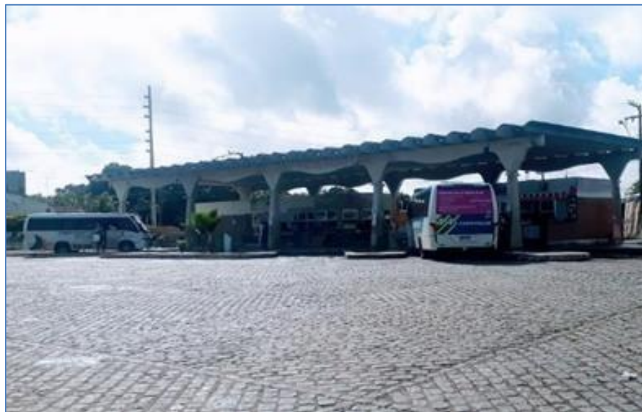
Foto 40 - Terminal Rodoviário Jaime de Figueiredo Lima.
