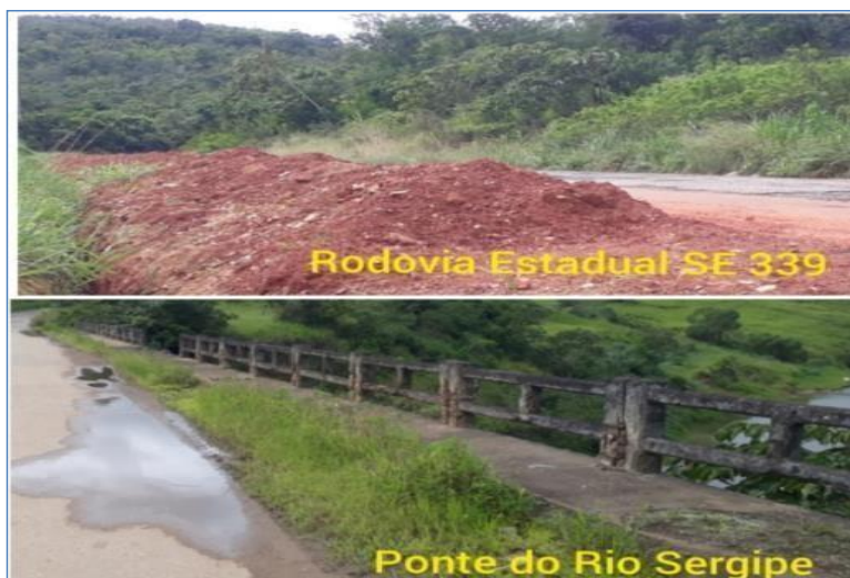
Foto 39 - Rodovia SE 339 e Ponte sobre o Rio Sergipe.
