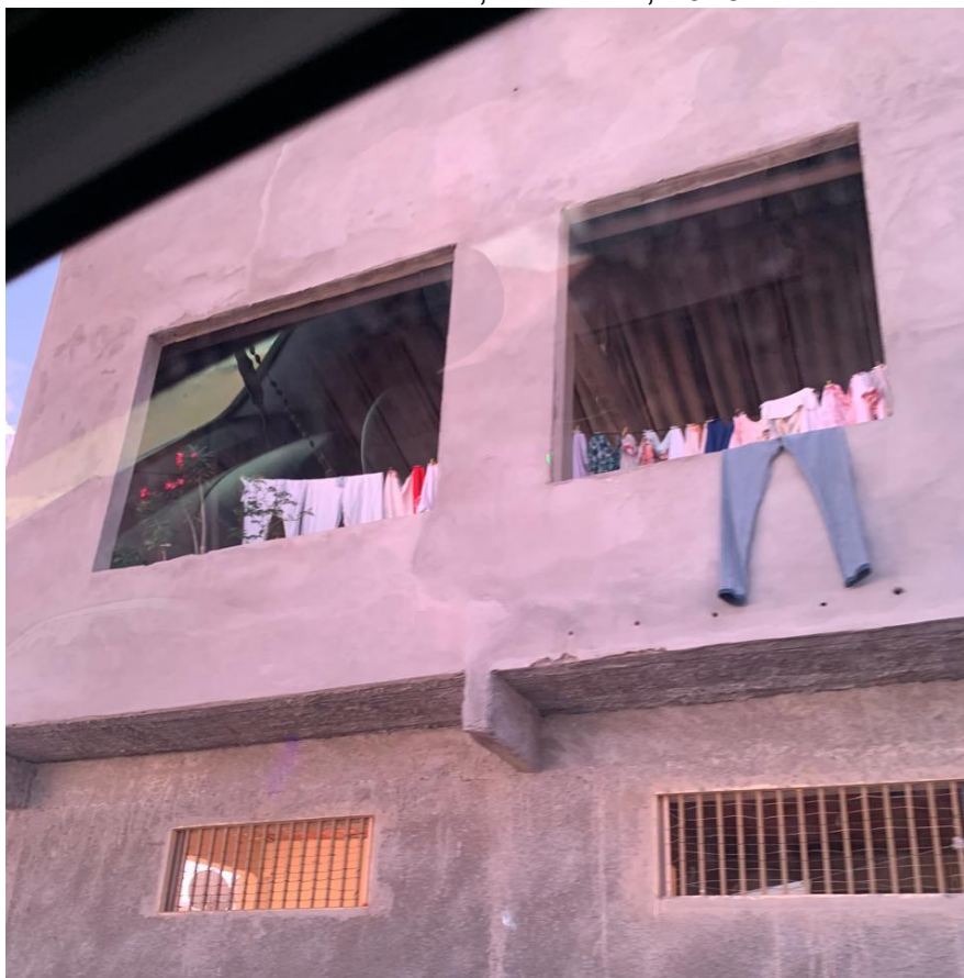
Foto 16: Reforma realizada em uma unidade habitacional do residencial Vida Nova Itaberaba, Itaberaba, 2025
