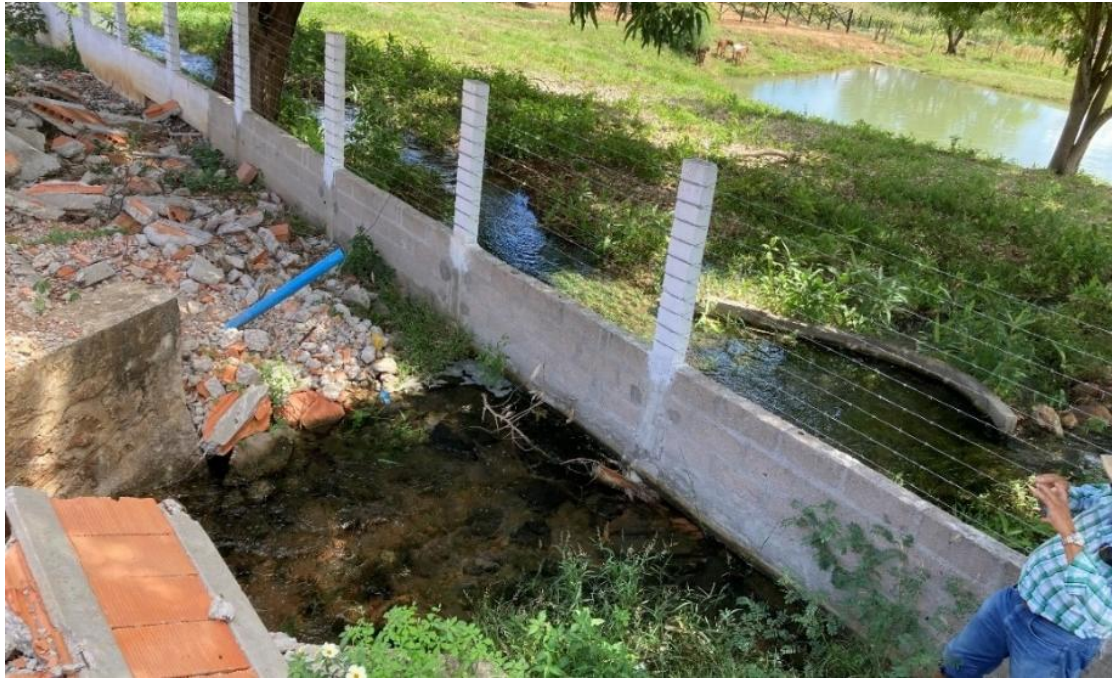
Figura 5 - Abastecimento irregular de reservatório em propriedade fora do projeto Califórnia.
