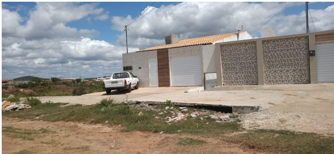
Figura 8 - Construção irregular sobre a estrutura do canal principal.
