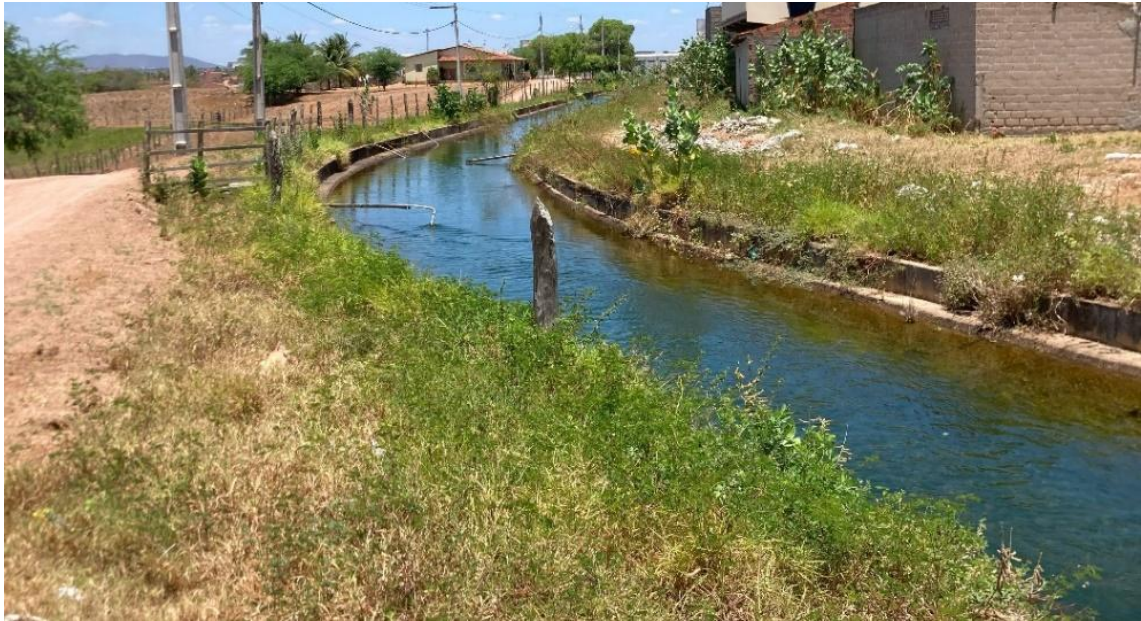
Figura 6 - Pontos de furtos de água por meio de canos inseridos no canal principal.
