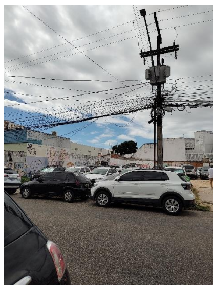
Figura 17 – Imóvel da Rua Duque de Caxias, 341, atualmente
