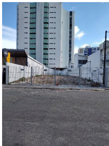
Figura 13 – Imóvel da Rua Senador Rollemberg, 205, atualmente
