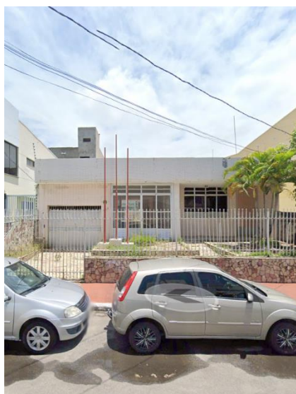
Figura 14 – Imóvel da Rua Vila Cristina, 206, em 2011
