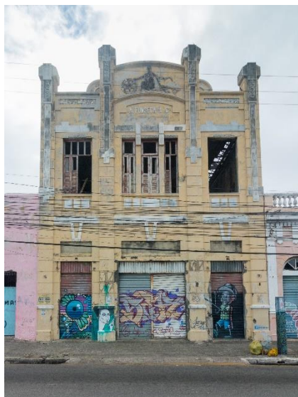
Figura 03 – Fachada da loja “A Fonseca & Cia” antes da demolição
