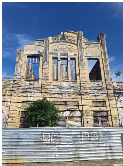
Figura 04 – Fachada da loja “A Fonseca & Cia” após a demolição
