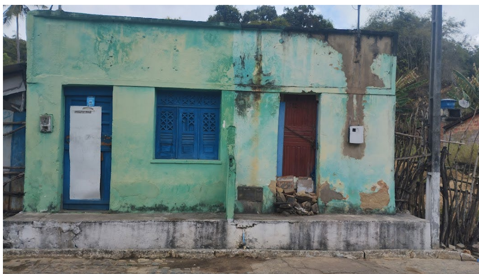
Figura 1. Casa do Mestre Zezinho, na Rua da Palha, em Laranjeiras. Ao lado, terreno onde havia o galpão onde o grupo ensaiava (Fonte: Arquivo pessoal, 2026).
