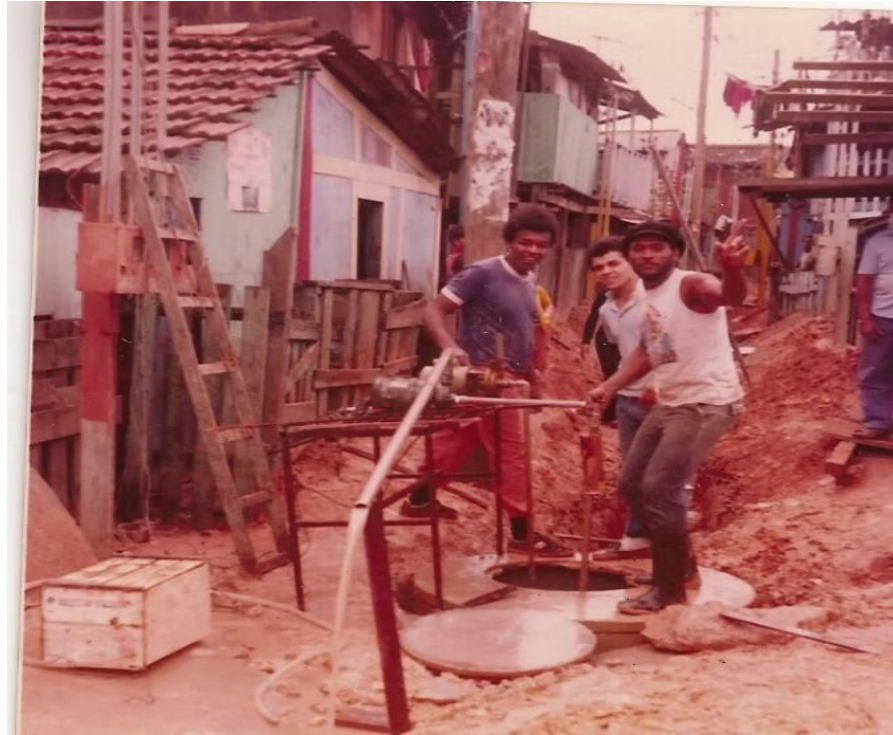
Figura 5 – MDF organiza mutirões para construção de esgotos (1984)
