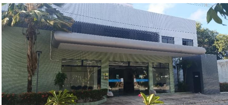
Figura 01: Fachada do Hospital Veterinário Universitário da Universidade Federal de Sergipe
