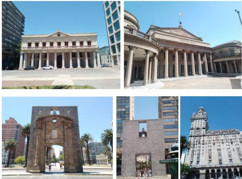
Fig. 19: Edificações históricas da Plaza de la Independência (Palácio Estéves, Teatro Solís, Porta da Cidadela e Palacio Salvo)
