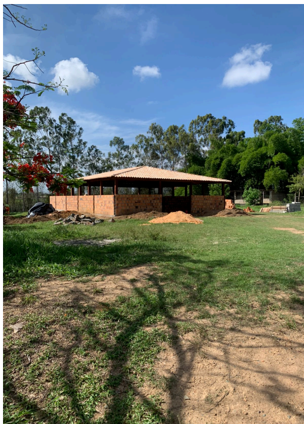
Figura 5: Pavilhão de baias em construção. Fonte pessoal.
