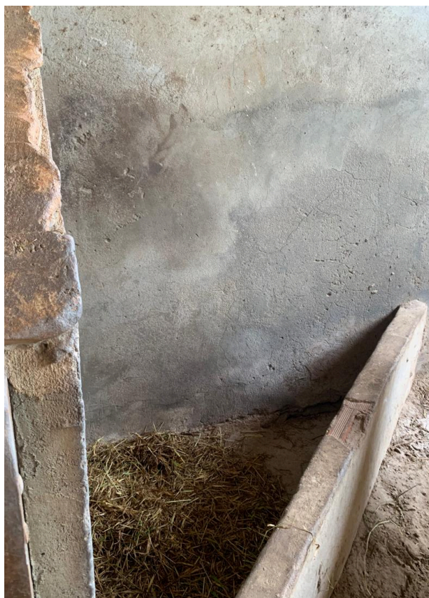
Figura 3: Comedouro destinado à oferta de forragem. Fonte pessoal.
