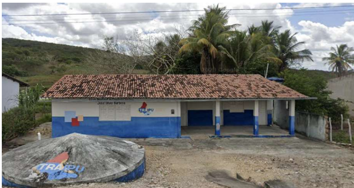
Figura 1 – Antiga fachada da Escola Municipal José Olímpio Barbosa
