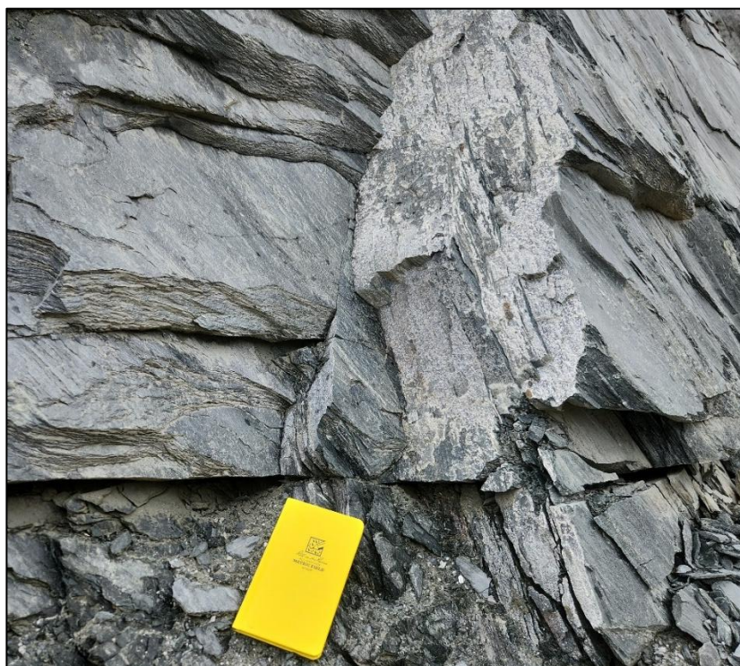
Figura 20 - Talude da litologia QCCX.
