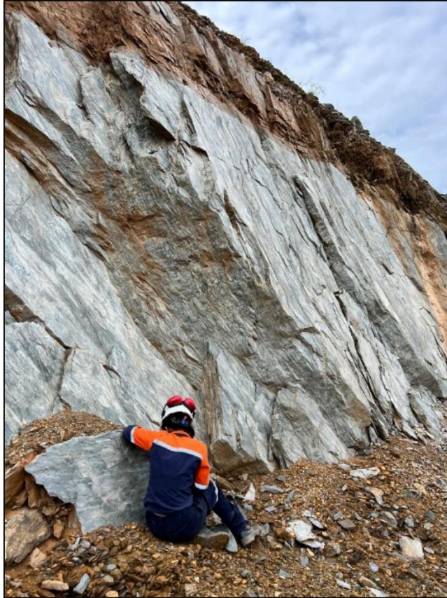
Figura 16 - Talude da litologia SDQX.
