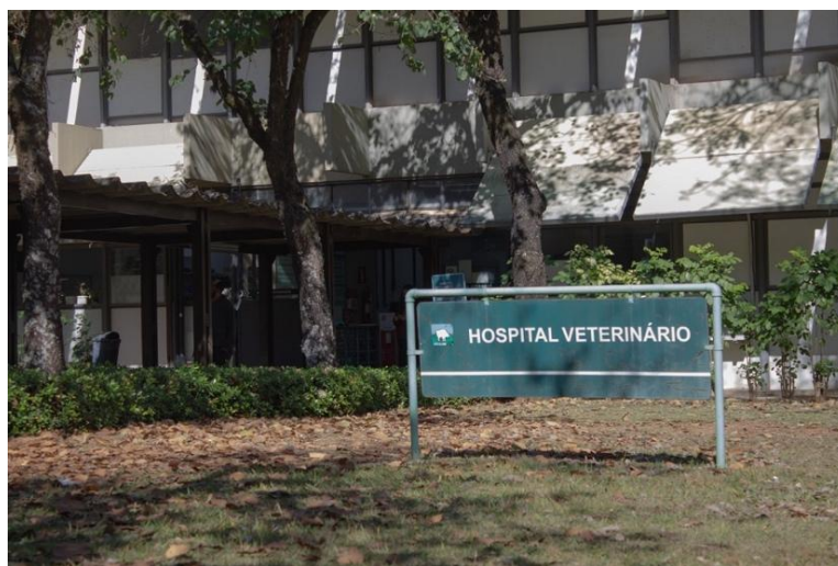
Figura 1. Fachada do Hospital Veterinário da UFMG. Fonte: UFMG.
