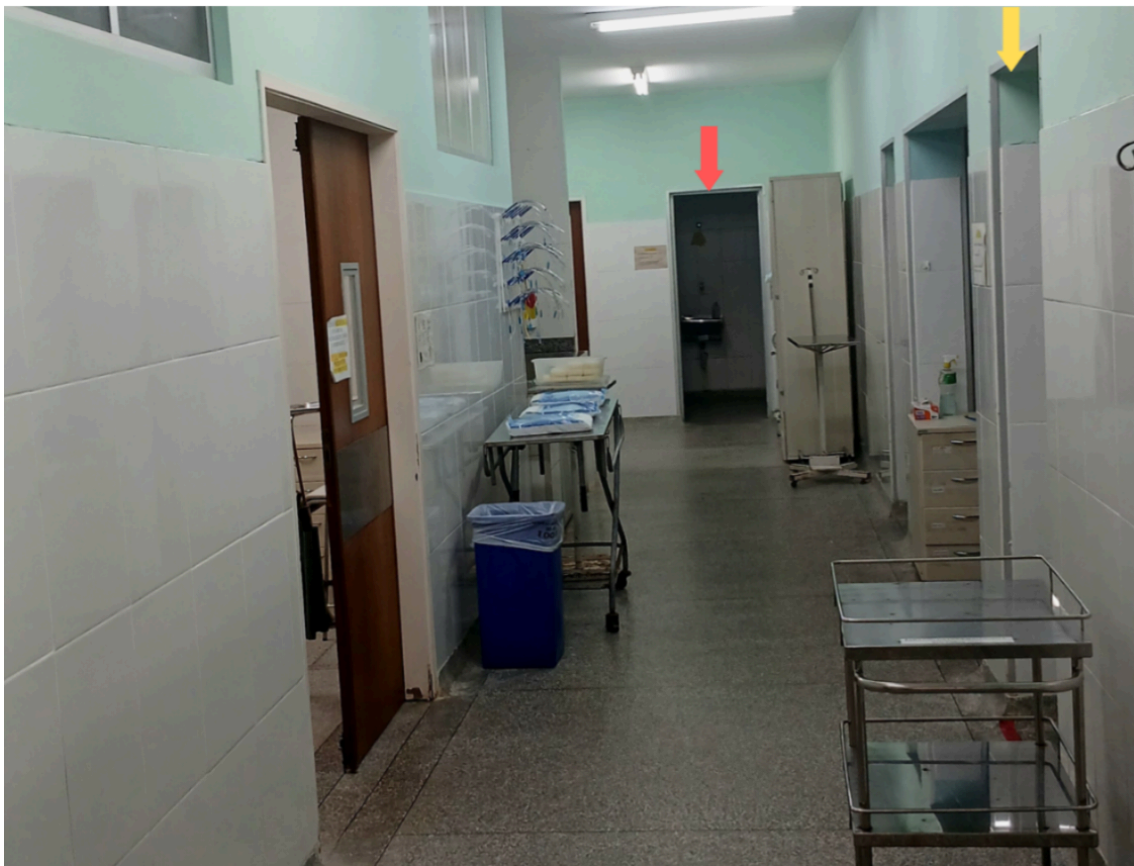
Figura 5- Corredor interno do centro cirúrgico, evidenciando porta de entrada (seta amarela) e a que leva até a saída (seta vermelha).
