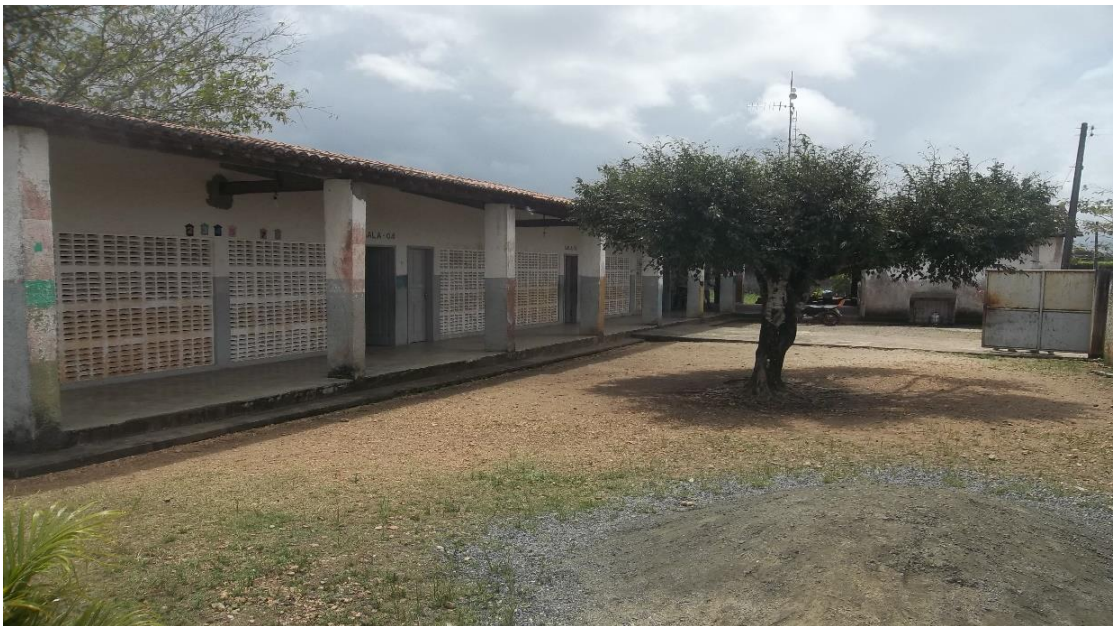
Foto 04 Interior da escola (corredores e salas de aula)
