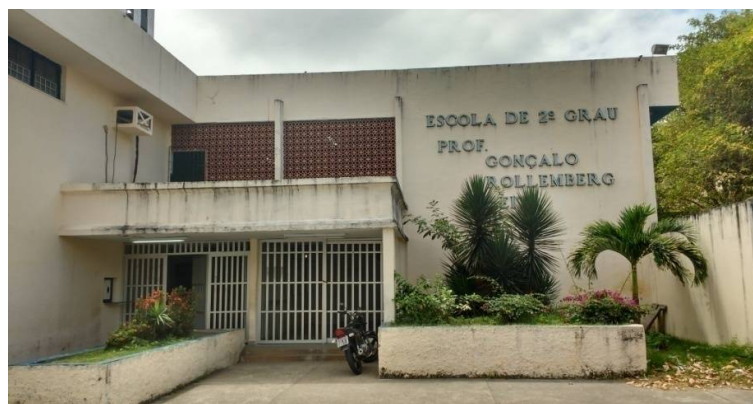
Fotografia 1: Fachada da Escola
