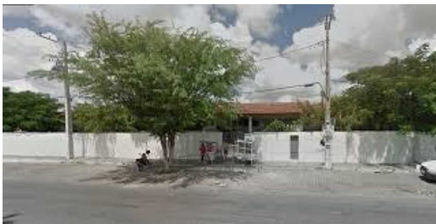
Figura 1- Fachada do Prédio da Escola Estadual 28 de Janeiro, localizada na Cidade de Monte Alegre/SE, Ano 2013. Fonte: Autores.
