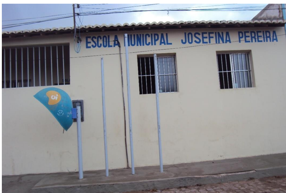
FOTO 01 – FACHADA DA ESCOLA MUNICIPAL JOSEFINA PEREIRA
