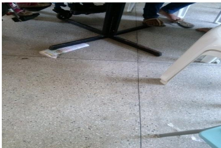
Imagem 3: Mesa danificada na sala de recursos, mesmo após a reforma iniciada em 2014 e finalizada no início de 2015. Fonte: autora, agosto 2015.
