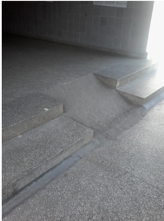
Figura 16: Rampa de Acesso ao 2º bloco Fonte: Foto de Edenilde
