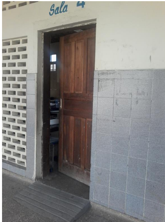
Figura 10: Sala de Aula com rampa de acesso Fonte: Foto de Edenilde
