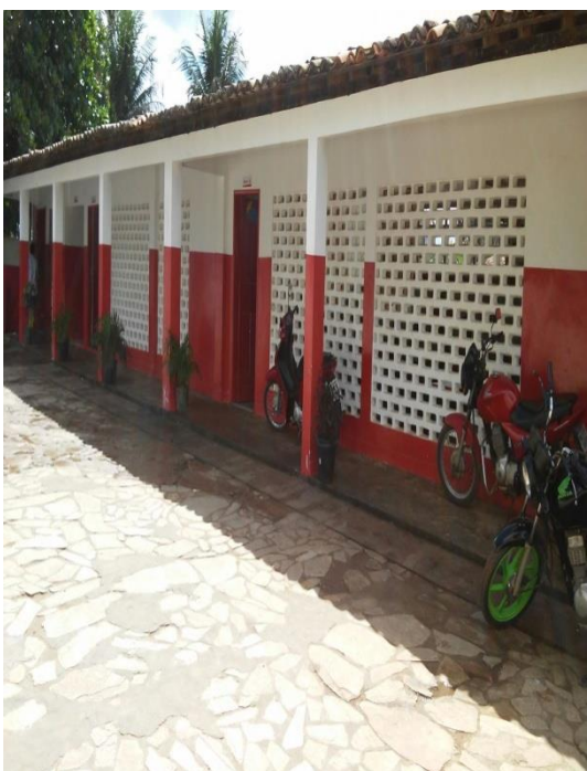
Fotografia 6: Espaço interno da escola, 2015.
