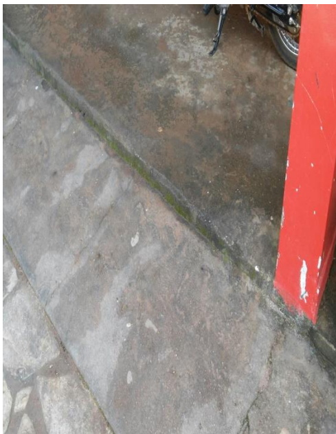
Fotografia 4: Espaço interno da escola, 2015.
