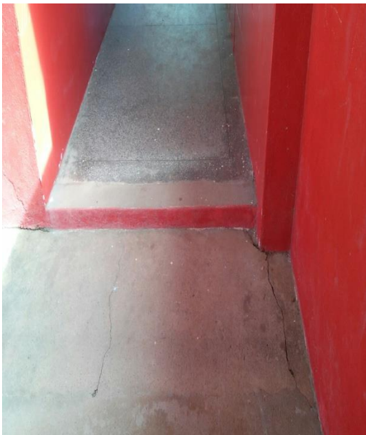
Fotografia 3: Espaço interno da escola, 2015
