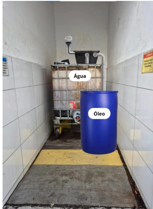
Figura 15 - Projeto separador água/óleo
