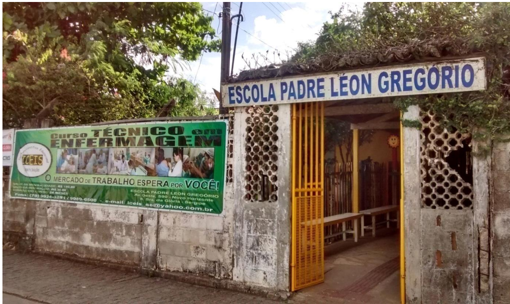
Foto 01- Fachada da Escola Padre León Gregório, 2015
