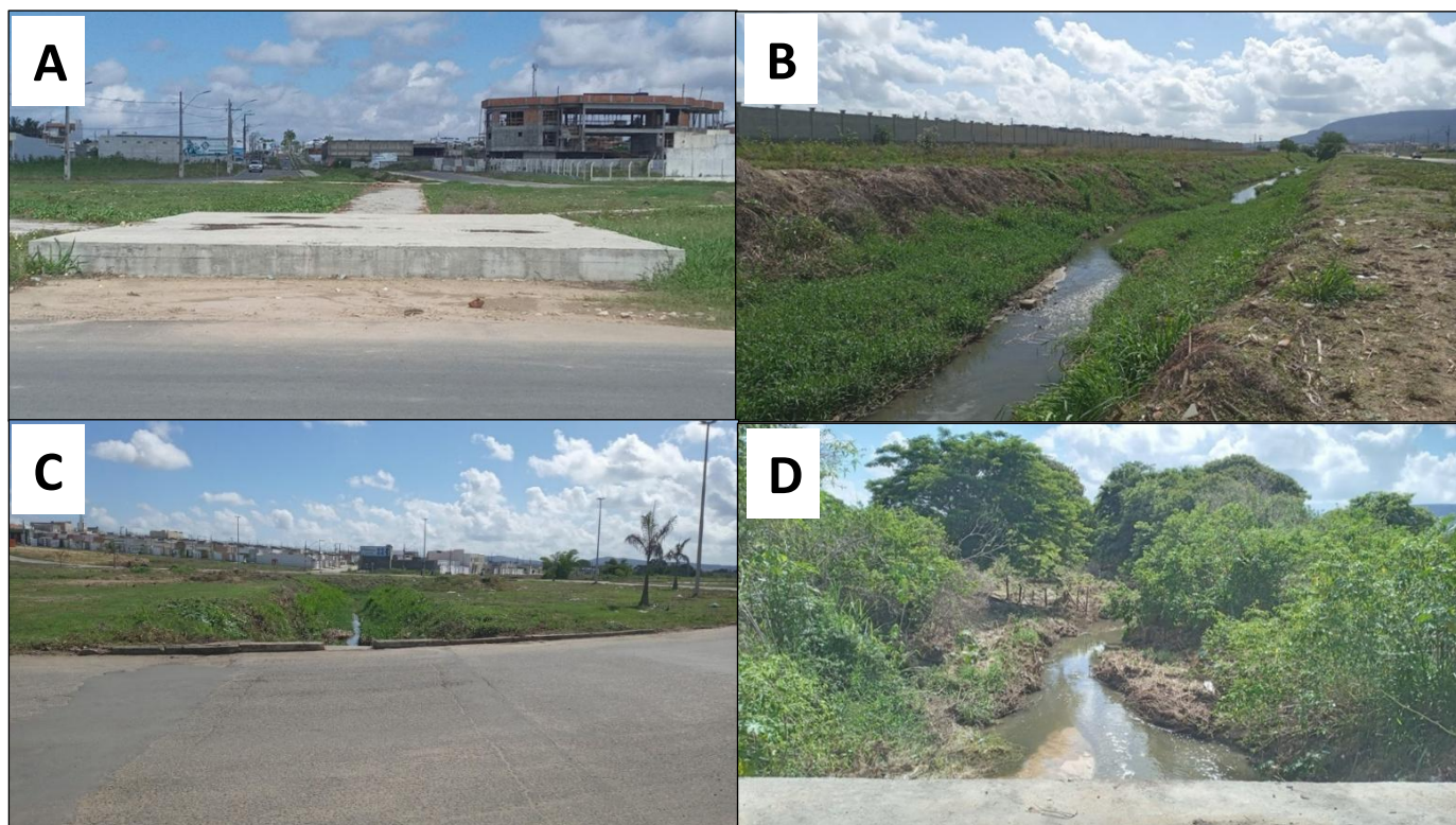
Figura 28: Pontos de registro do canal “principal” do bairro Anísio Amâncio
