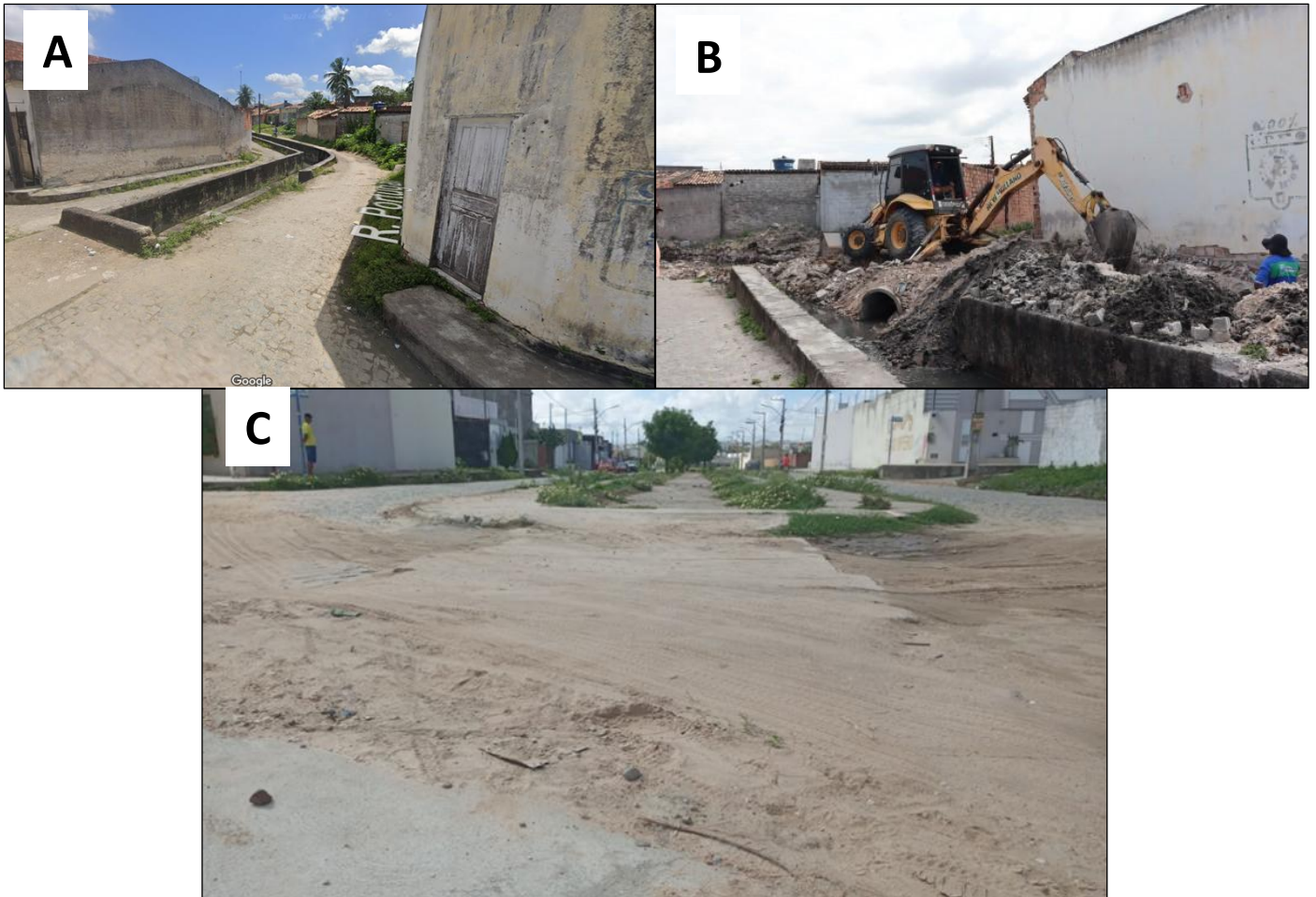
Figura 22: Pontos de registros do canal Açude Velho
