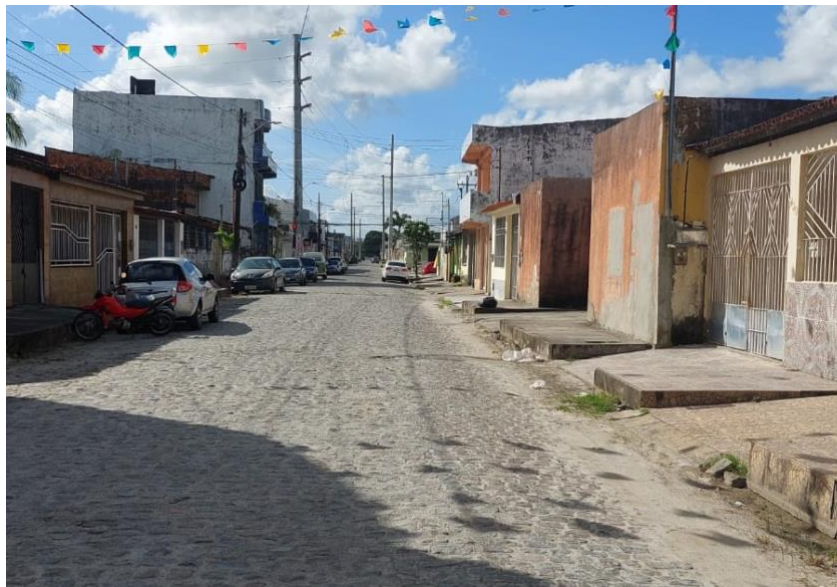
Figura 09 São Cristóvão Rosa Elze Rua com Pavimentação precária 2025
