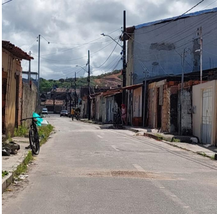
Figura 10 Aracaju Bairro Industrial Pavimentação precária 2025
