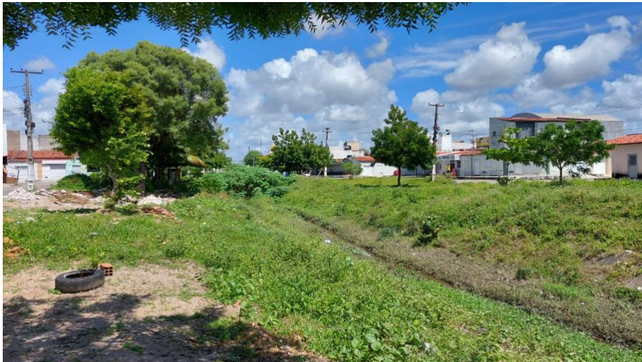
Figura 04 Nossa Senhora do Socorro Marcos Freire II Canal sem tratamento de esgoto 2025
