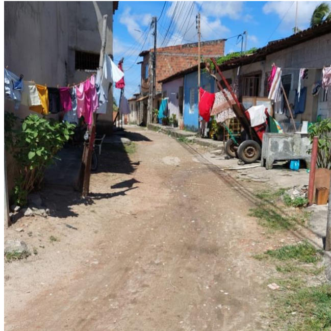
Figura 15 Nossa Senhora do Socorro Marcos Freire III Ausência de calçamento 2025
