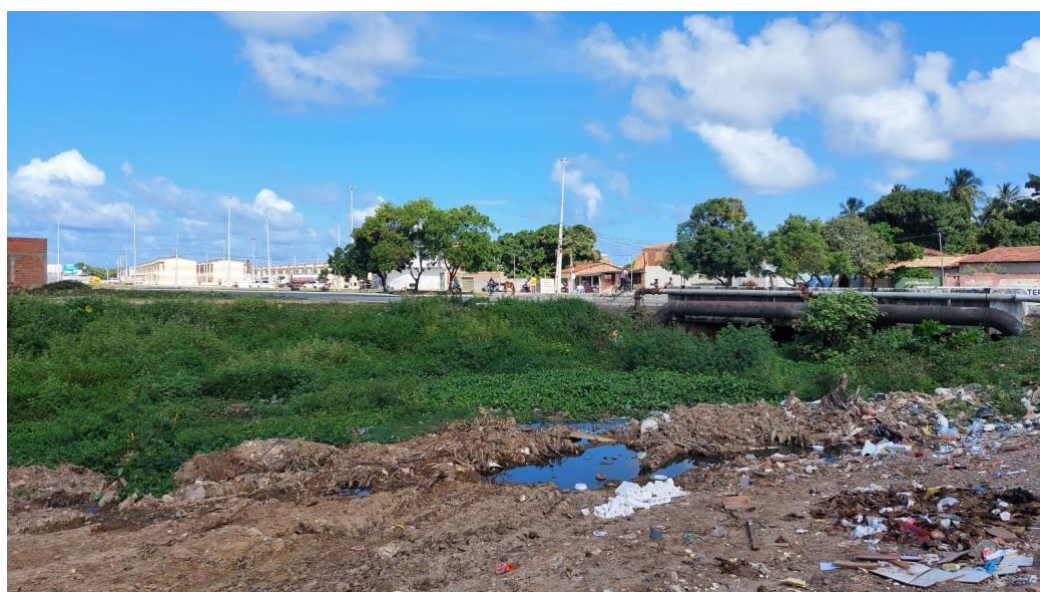
Figura 14 Aracaju Bairro Santa Maria Canal sem tratamento de esgoto 2025
