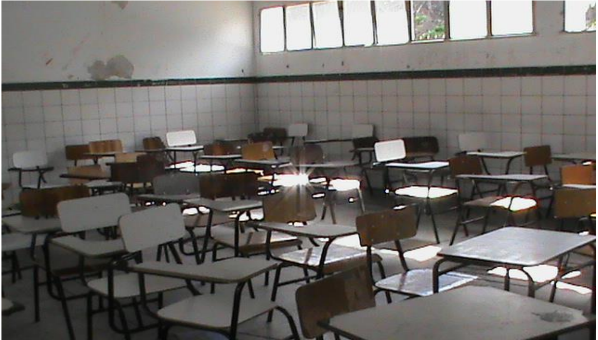
Foto 11: Interior de sala de aula da E. M. Ver. Genésio Santana
