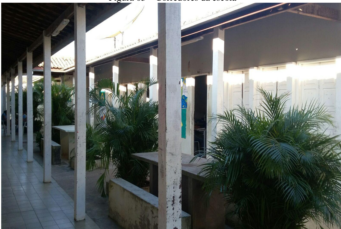
Figura 03 – Corredores da escola
