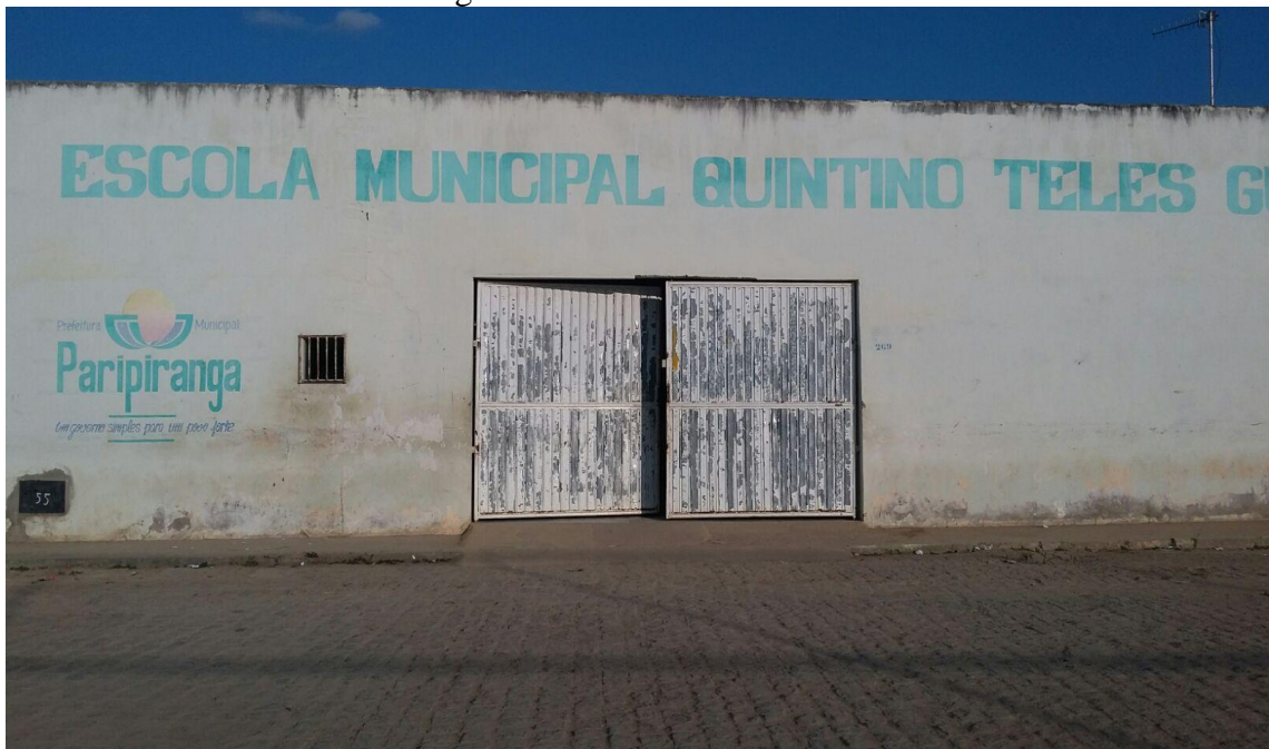
Figura 01 – fachada da escola
