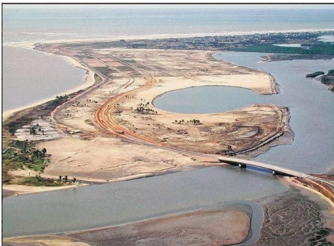
Figura 4 – Terreno da Coroa do Meio
