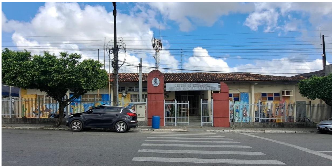
Fig. 13: Fachada do Centro de Excelência Senador Gonçalo Rollemberg, Japaratuba/SE Fonte: Foto autoral, 2024.
