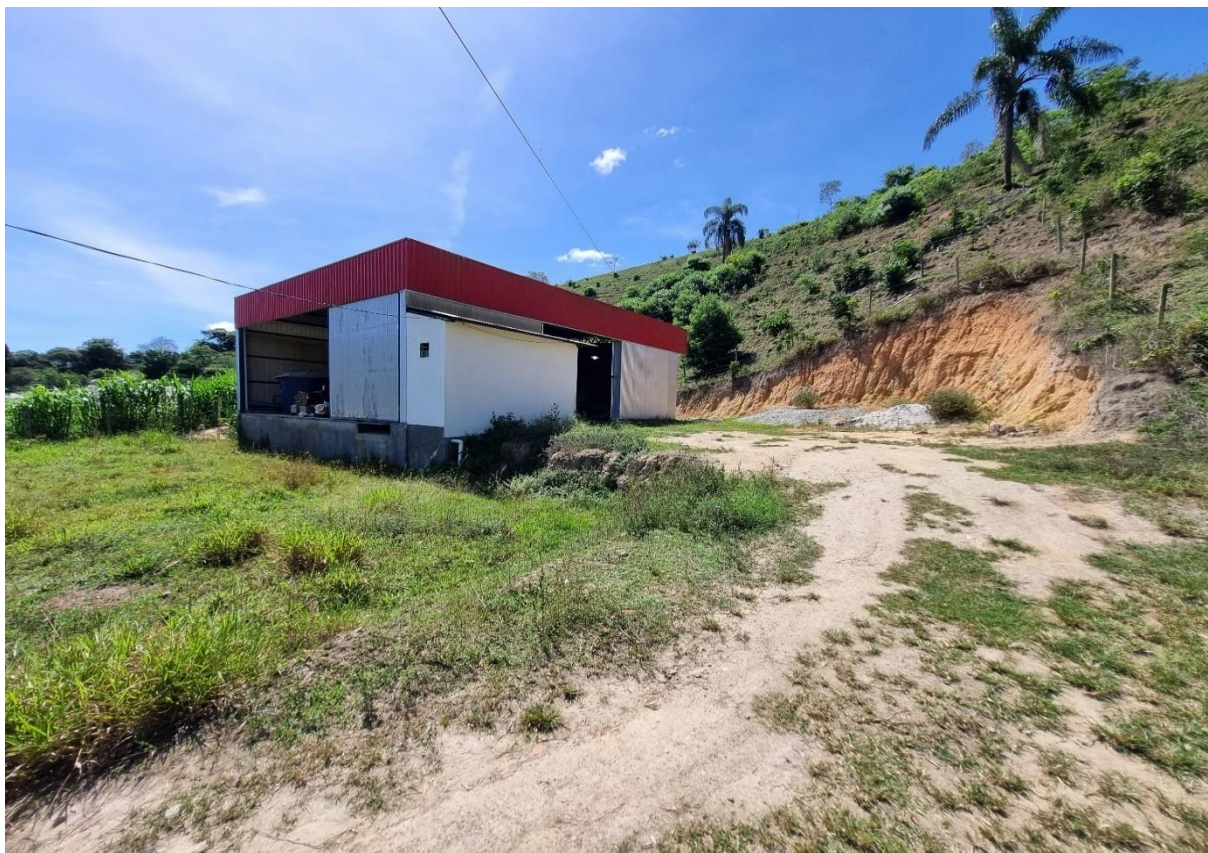
Fotografia 8 e 9 - Galpão da Peterfrut no município de Planalto/BA
