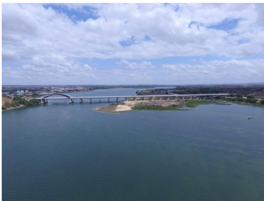
Figura 5 – Ponte Godofredo Diniz sobre o Rio São Francisco, divisa entre Sergipe e Alagoas
