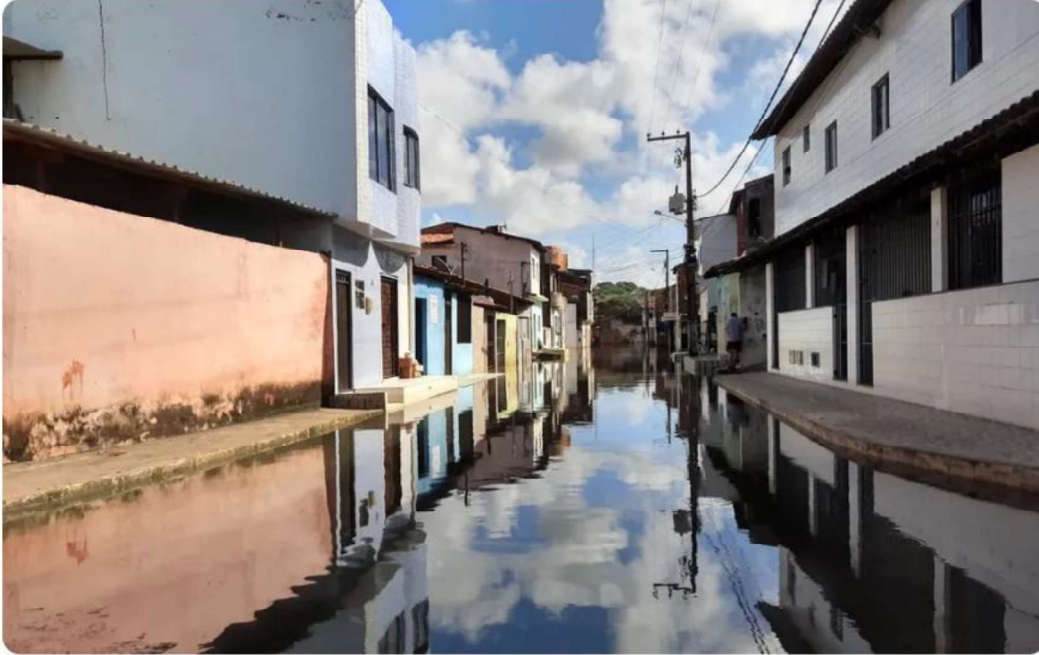
Figura 2.4 - Evento de inundação no bairro Jabotiana em 2020.
