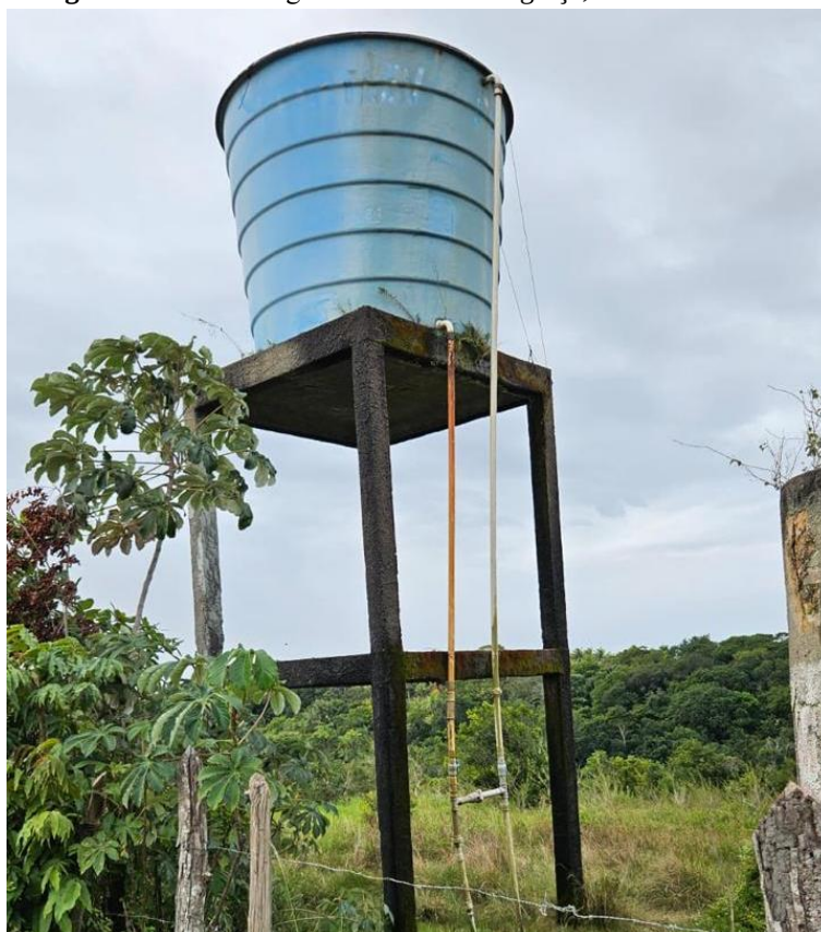
Figura 6 – Caixa d'água do Povoado Preguiça, em Indiaroba/SE.
