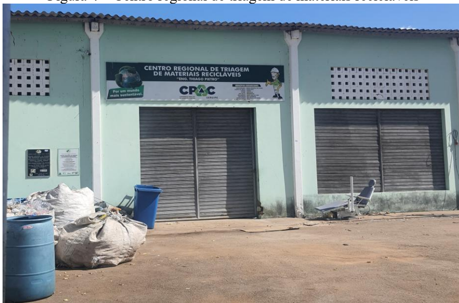
Figura 4 – Centro regional de triagem de materiais recicláveis
