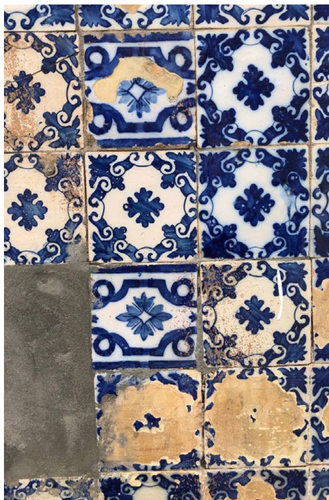
Figuras 8, 9 e 10. Danos em fachadas azulejares em Estância. Da esquerda pra direita: Edificação N.º 442 – F2, Edificação N.º 442 – F8, Edificação N.º 228 – F5. Fonte: Acervo pessoal da autora, 2025.
