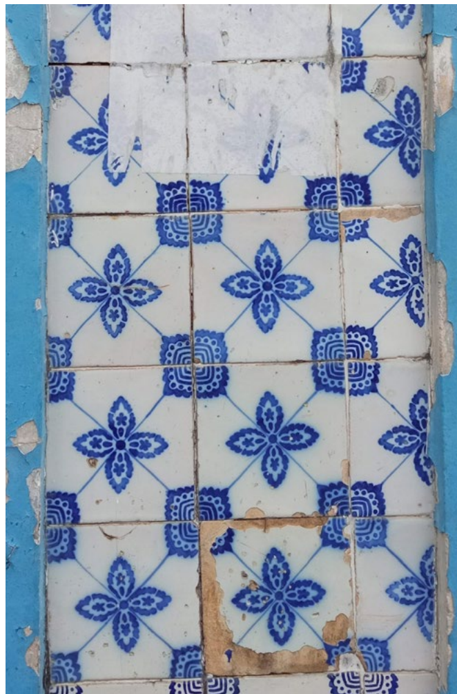
Figuras 5, 6 e 7. Danos em fachadas azulejares em Estância. Da esquerda pra direita: Edificação N.º 442 – F2, Edificação N.º 228 – F5, Edificação N.º 120-122 – F3. Fonte: Acervo pessoal da autora, 2025.
