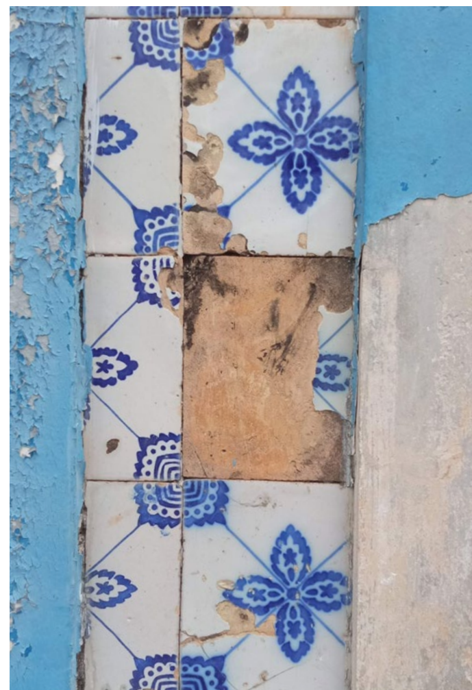
Figuras 8, 9 e 10. Danos em fachadas azulejares em Estância. Da esquerda pra direita: Edificação N.º 442 – F2, Edificação N.º 442 – F8, Edificação N.º 228 – F5. Fonte: Acervo pessoal da autora, 2025.
