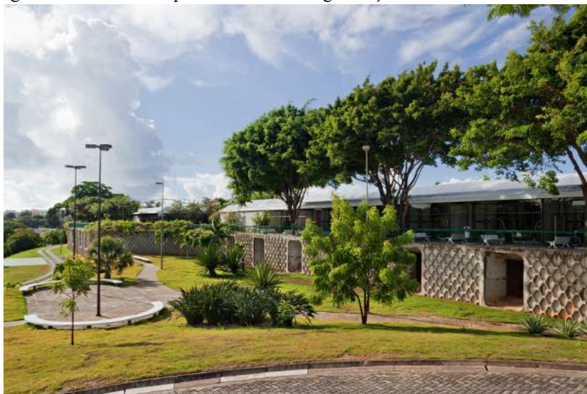
Figura 23: Vista do Hospital mostrando integralização entre o interno e o externo
