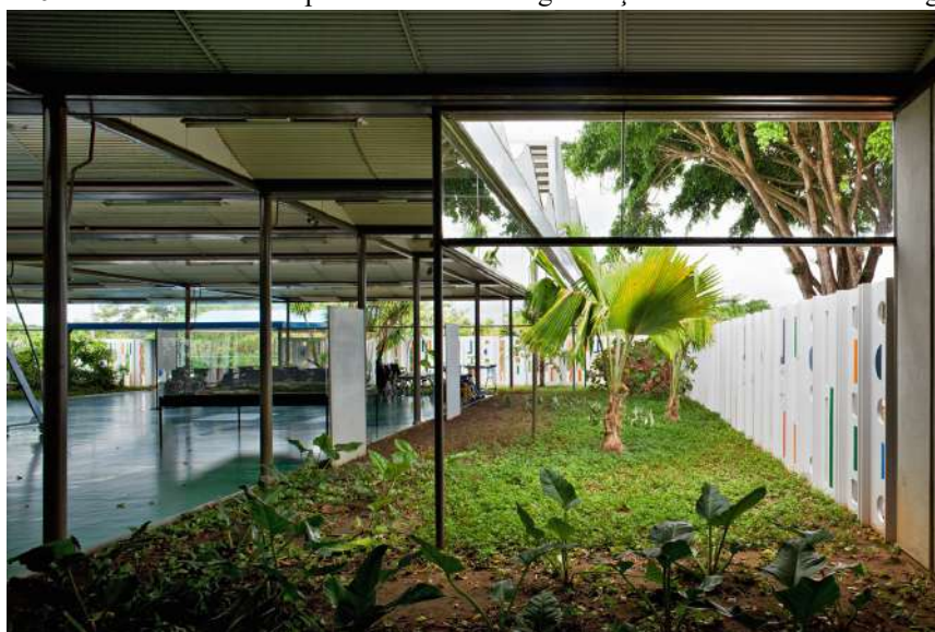
Figura 26: Vista interna do Hospital mostrando integralização entre os ambiente a vegetação
