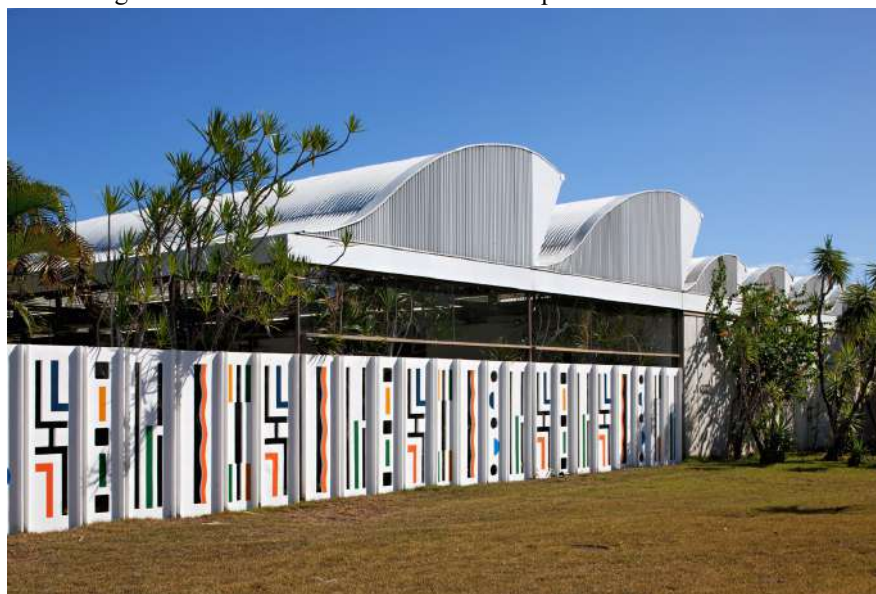
Figura 27: Vista do limite do terreno com painéis de Athos Bulcão
