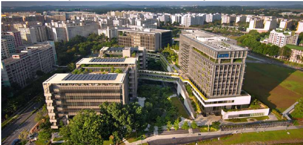
Figura 34: Vista aérea do Khoo Tech Puat Hospital (KTPH)
