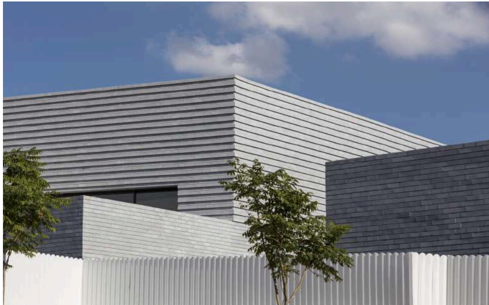
Figura 17 - Acabamento com tijolos cinzas.
