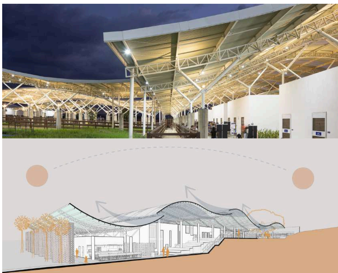
Figura 26 - Cobertura Metálica no Hospital Veterinário Escola da Unileão.
