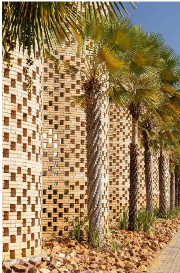
Figura 27 - Brise Solar no Hospital Veterinário Escola da Unileão.
