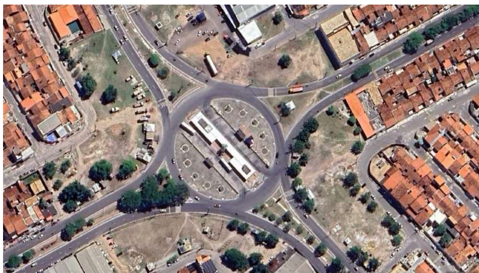
Figura 31 - Entorno do terminal visto de cima, pouca arborização.
