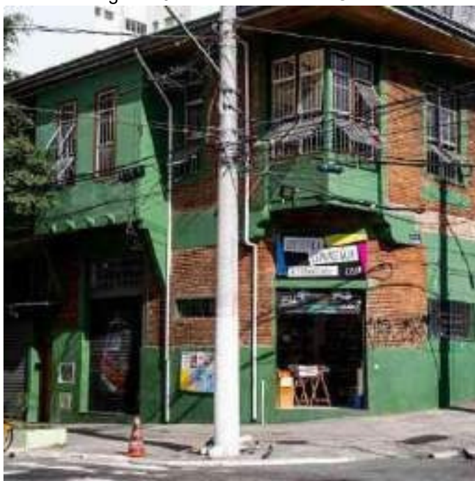
Figura 25 - Vista do Sobrado Casa 1
