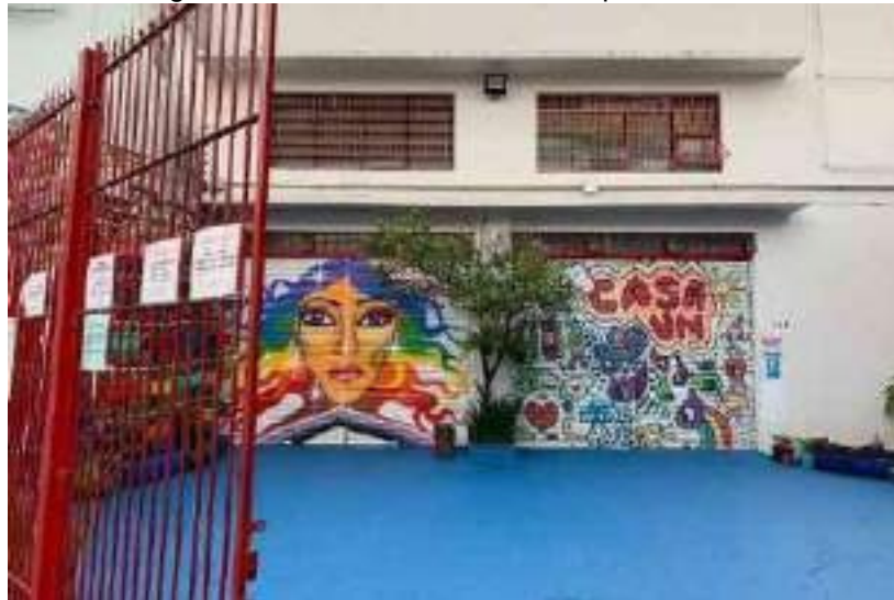
Figura 30 - Fachada Frontal do Galpão Casa 01
