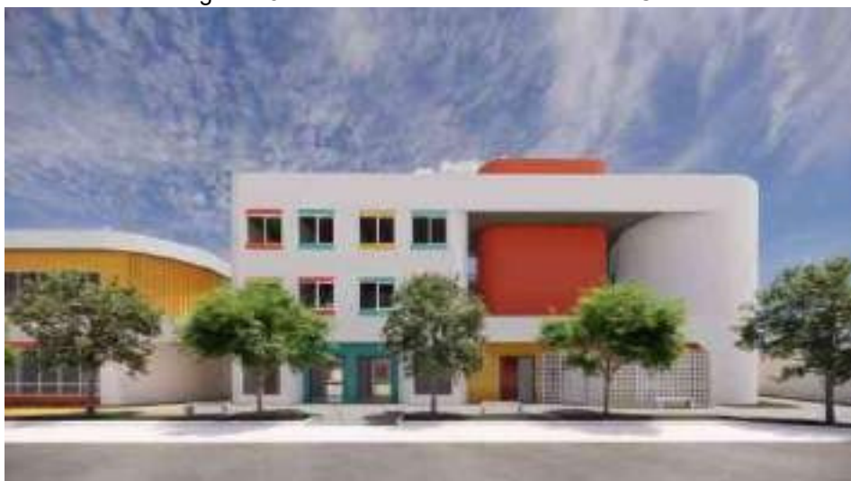
Figura 75 - Fachada da rua Pedro Vitor da Cruz
