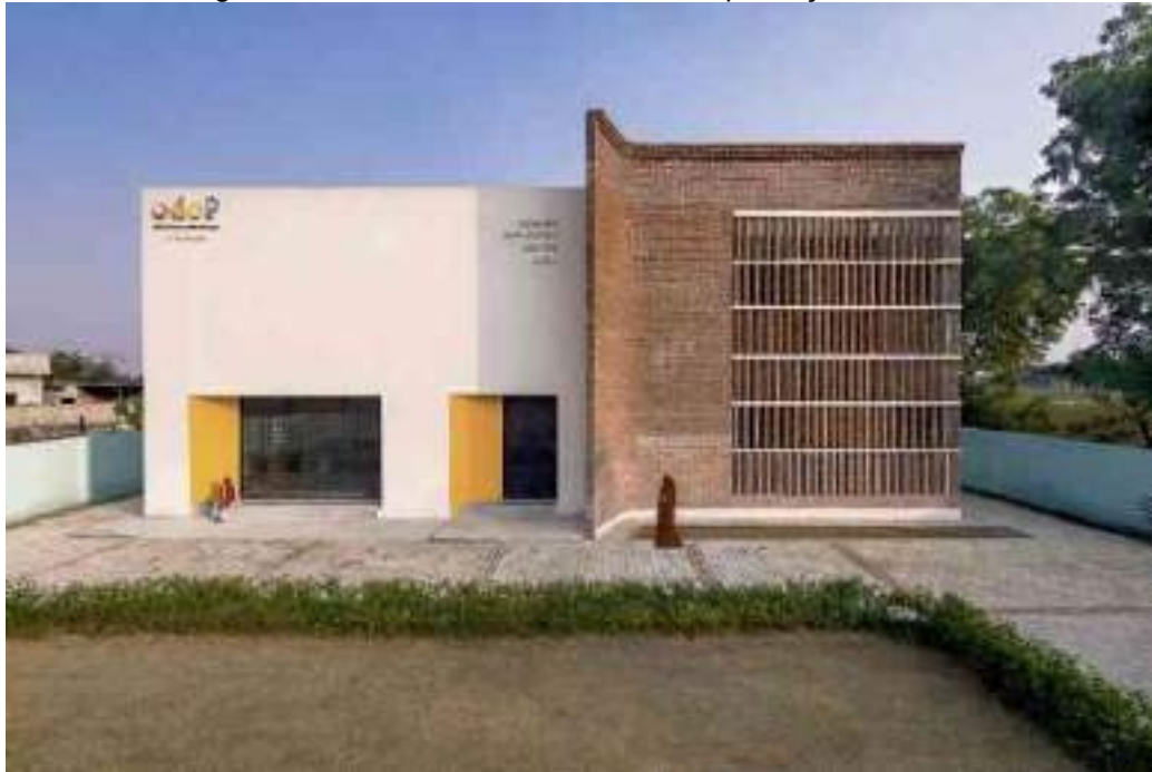
Figura 37 - Vista frontal do Centro de Capacitação Comum.
