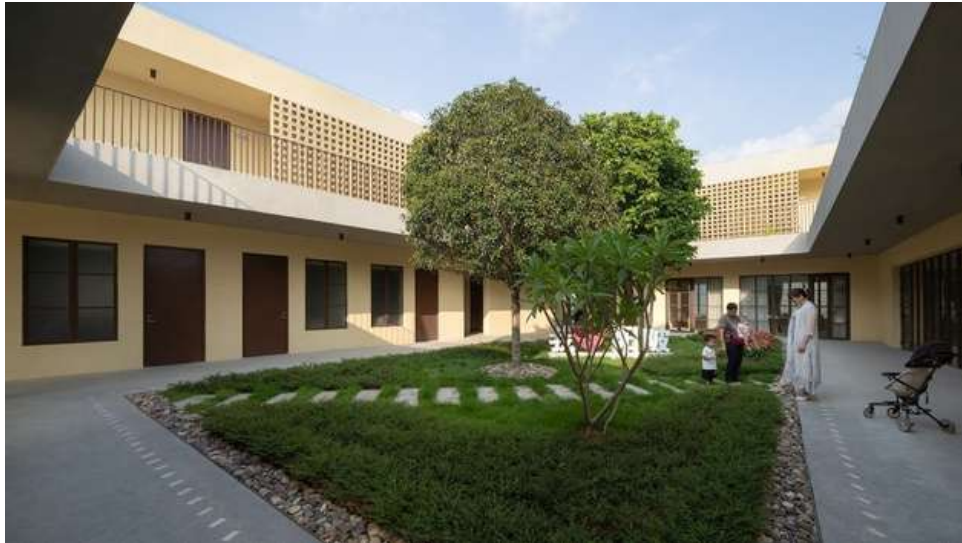
Figura 33 - Cobogós existentes no segundo pavimento
