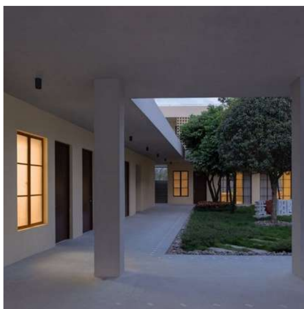
Figura 31 - Beiral expressivo para controle de incidência solar no térreo - Centro de Cuidado Diurno para Idosos
