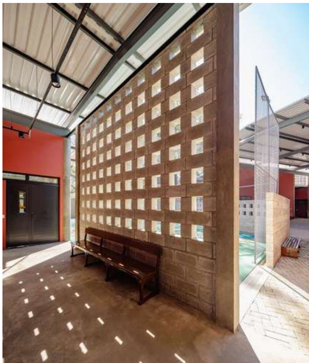
Figura 35 - Abertura para ventilação e iluminação
