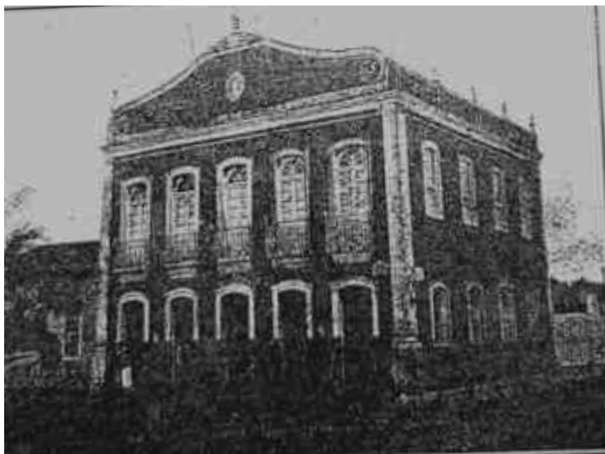
Figura 24 – Fachada antiga do atual prédio do Paço Municipal de Estância em 1920
