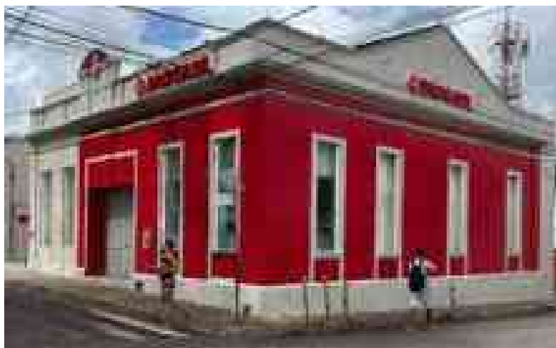
Figura 63 – Fachada da Antiga Biblioteca Municipal Monsenhor Silveira
