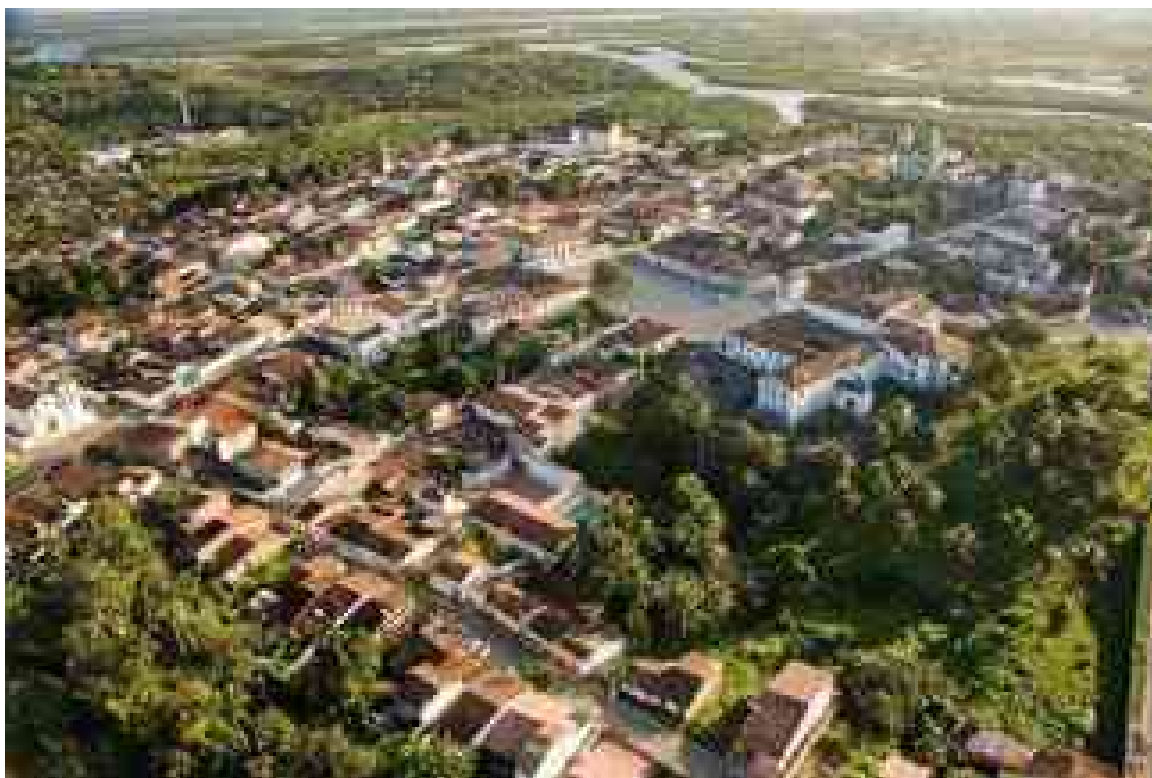
Figura 11 – Vista aérea do centro histórico de São Cristóvão, Sergipe (s.d.)
