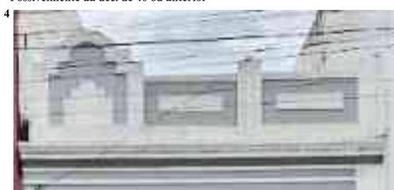
Detalhe platibanda em Ago. de 2025
