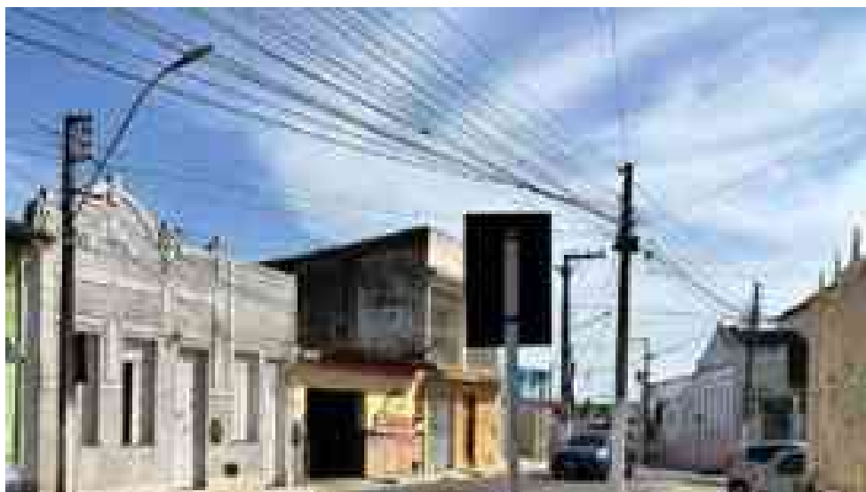
Figura 104 – Poluição visual causada pela infraestrutura elétrica
