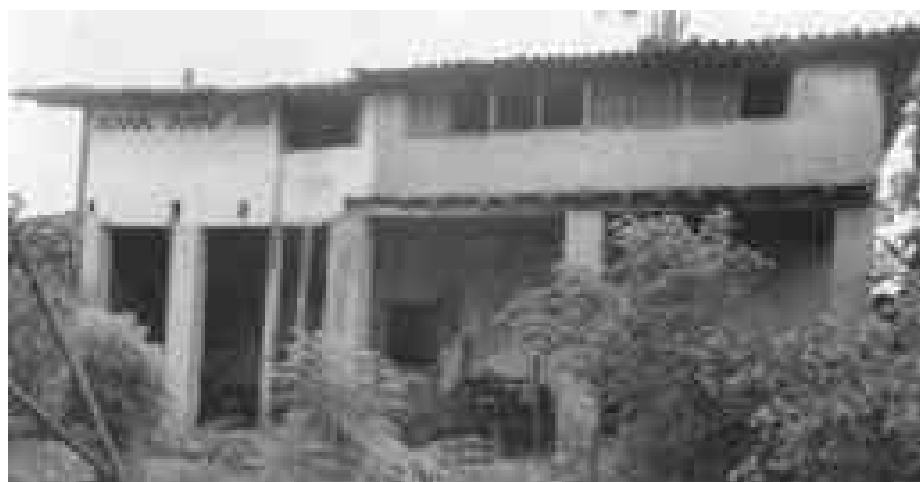
Figura 94 – Fachada posterior da Edificação número 20/ sobrado n° 35
