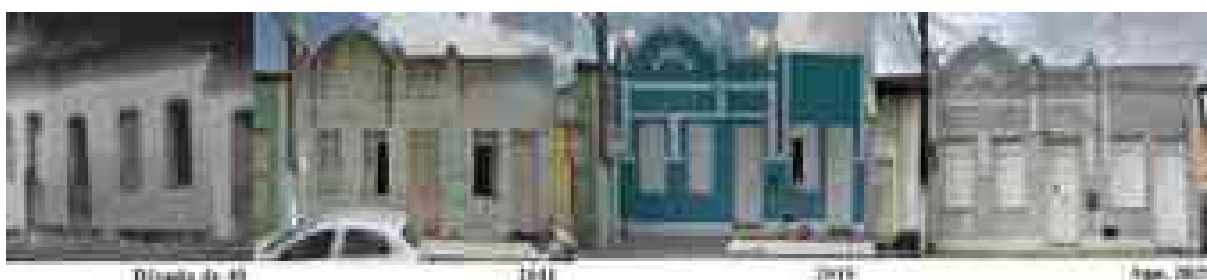
Figura 82 – Alterações na fachada da edificação número 16
