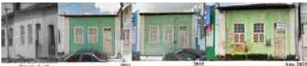
Figura 84 – Alterações na fachada da edificação número 17
