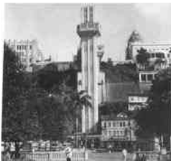
Figura 36 – Fachada art déco do elevador Lacerda, Salvador/BA após reforma de 1934.
