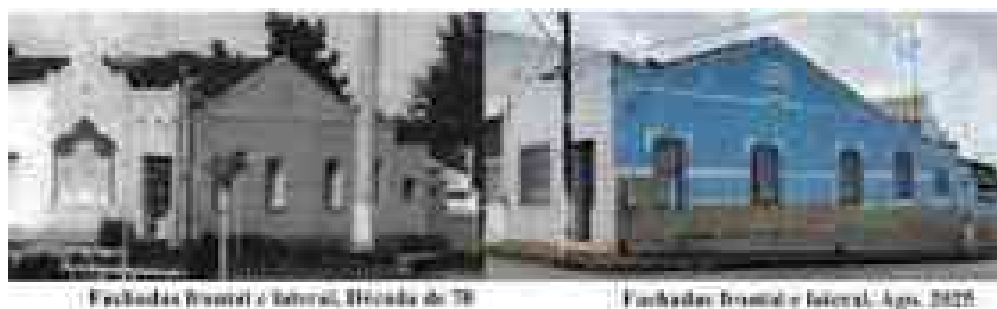
Figura 101 – Alterações de fachada lateral da edificação n° 22
