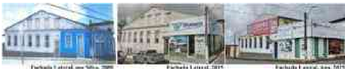
Figura 97 – Alterações na fachada da edificação número 21
