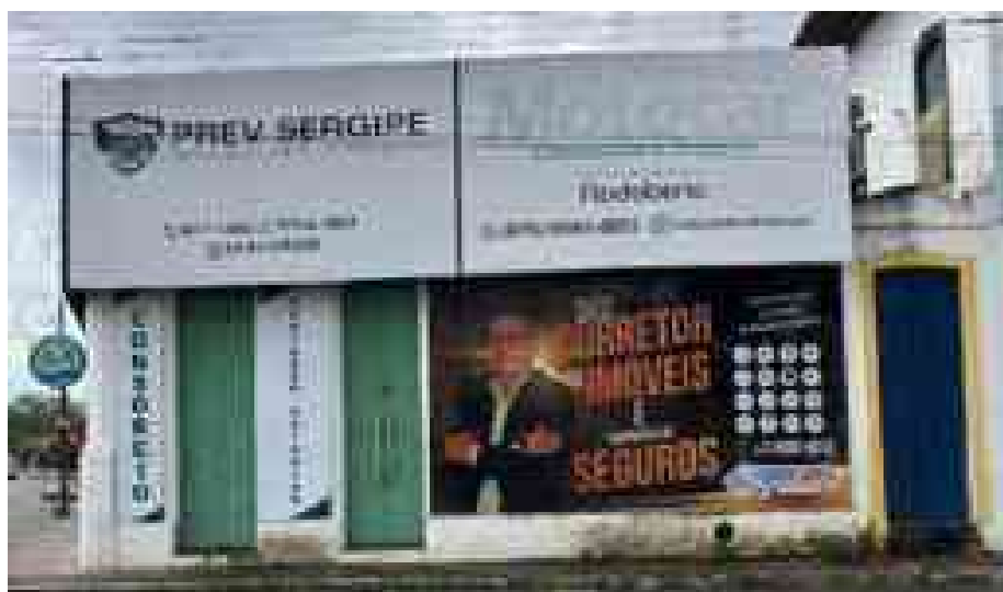
Figura 96 – Edificação número 21, fachada sentido praça
