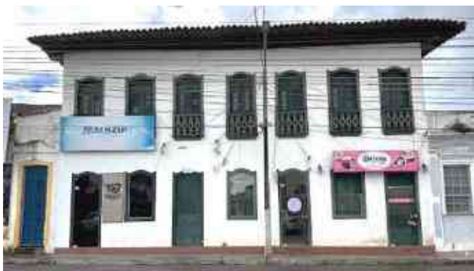
Figura 92 – Edificação número 20/ Sobrado nº 35
