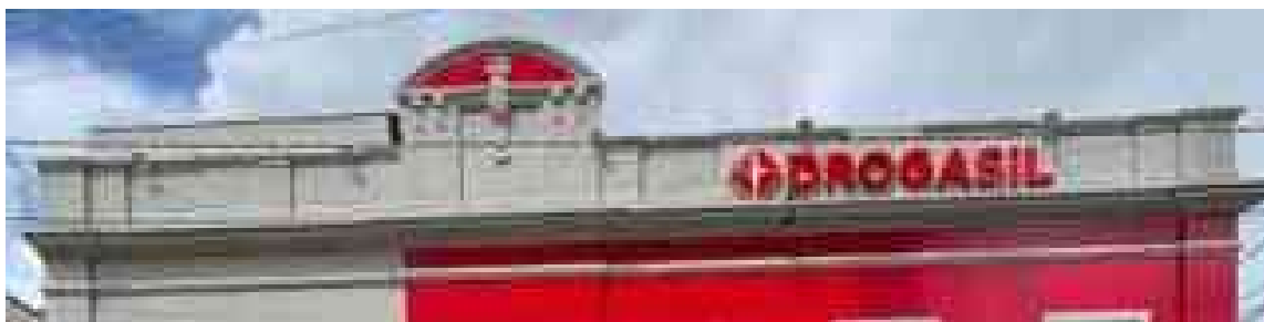
Figura 64 – Destaque do coroamento da edificação
