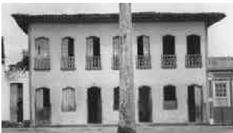
Figura 93 – Edificação número 20, na década de 50 (Pilares ainda à mostra)
