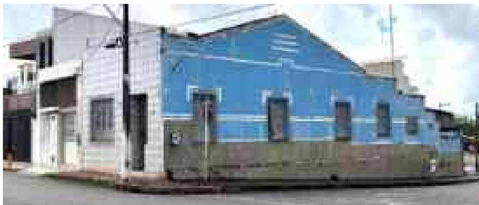
Figura 99 – Edificação número 22, fachada sentido praça
