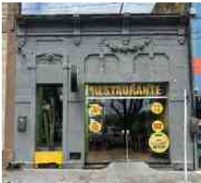
Figura 66 – Fachada da edificação número 10, antigo Nataboka Bar
