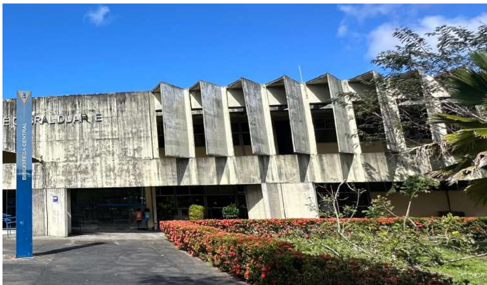
Figura 24 - Brises em concreto na fachada da biblioteca.
