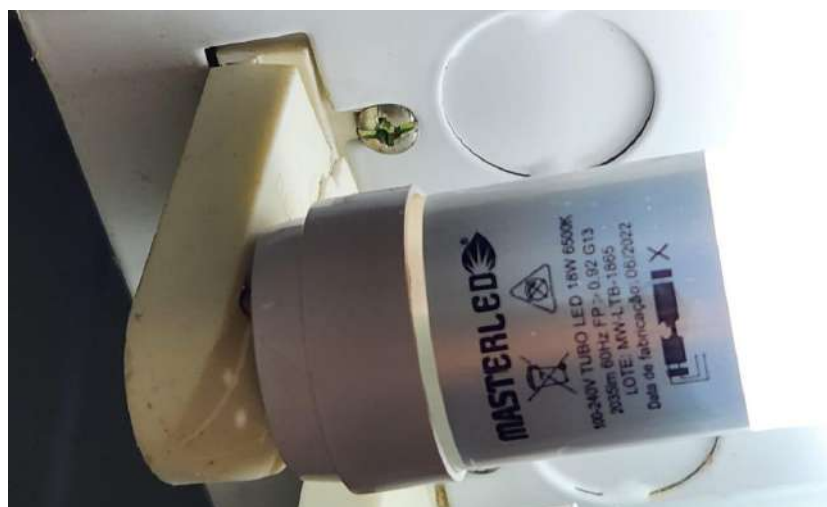
Figura 21 - Especificações das lâmpadas empregadas na biblioteca.
