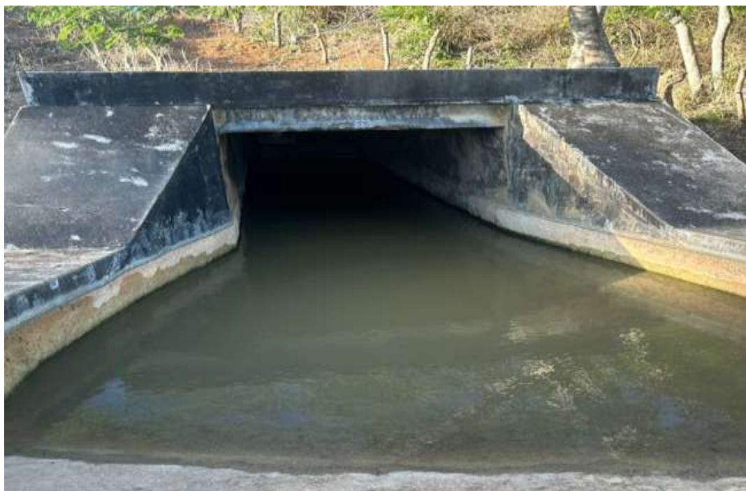
Figura 32: Bueiro construído pela construtora Mauritan-LTDA, Cutia.
