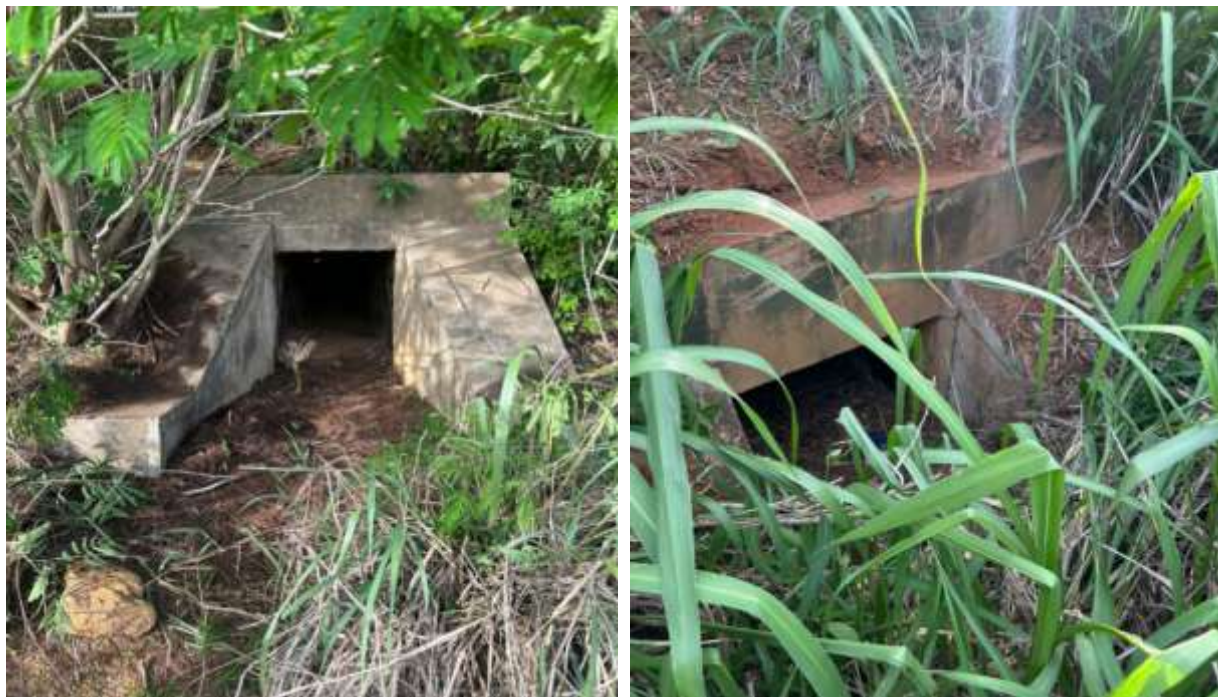
Figura 19: Bueiro localizado na Roça de Dentro, 2025.
