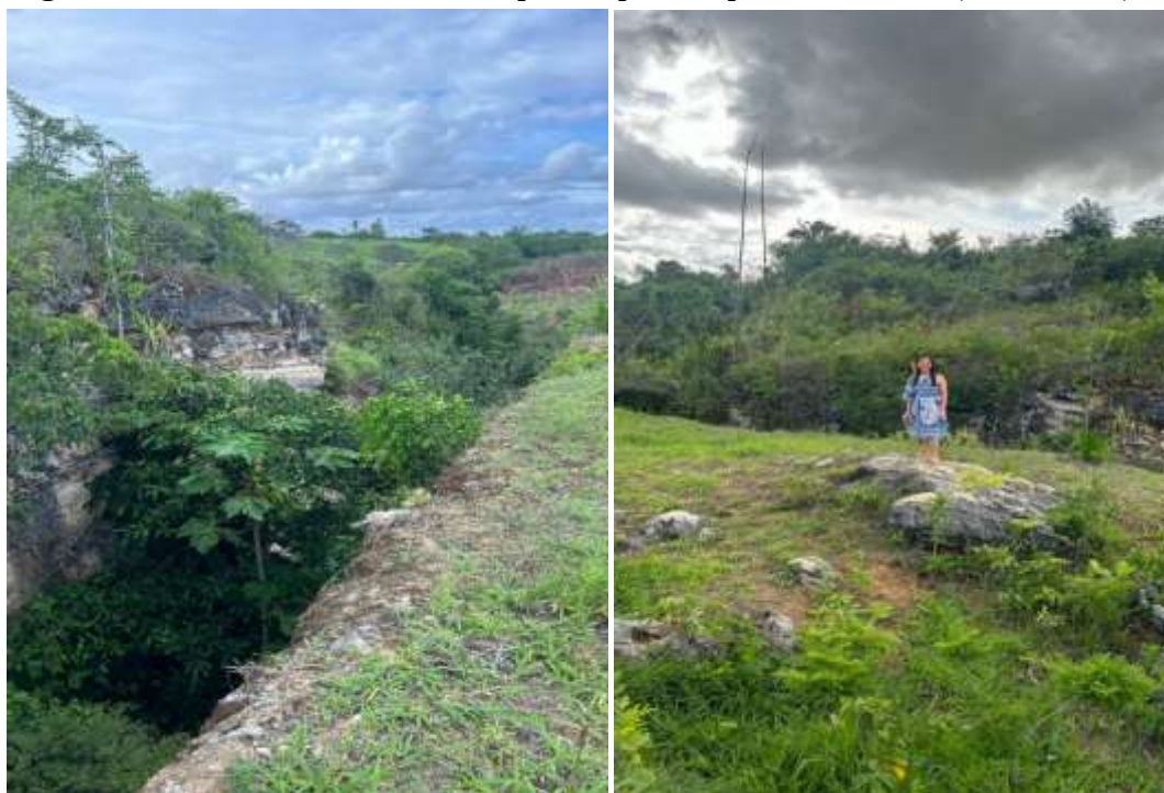
Figura 45: Corte e rochas deixadas pela explosão, povoado Sabão (09/02/2025)
