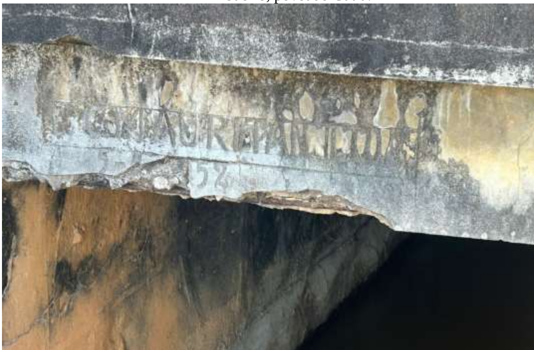
Figura 31: Empresa Mauritan-Ltda e registro da data em cimento e pedra no bueiro, povoado Cutia.
