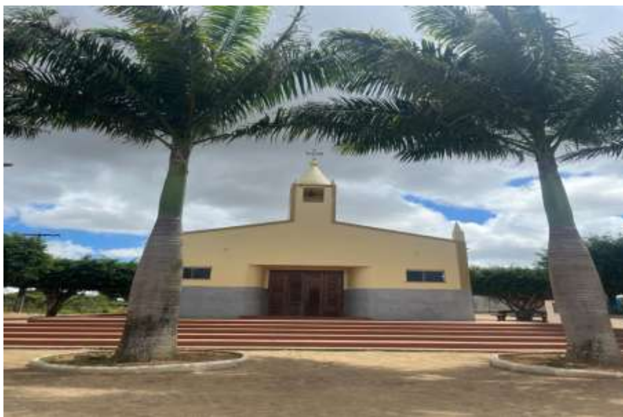
Figura 20: Capela de Nossa Senhora Aparecida, Roça de Dentro.
