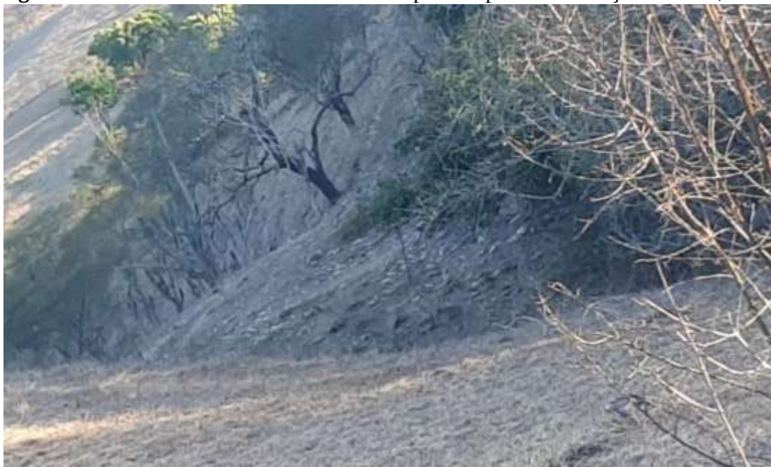
Figura 33: Aterro de rochas resultantes das explosões para a construção da linha, Cutia.
