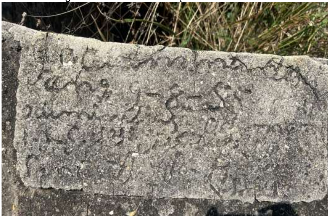
Figura 40: Placa de cimento e pedra com a data de 09/08/1955
