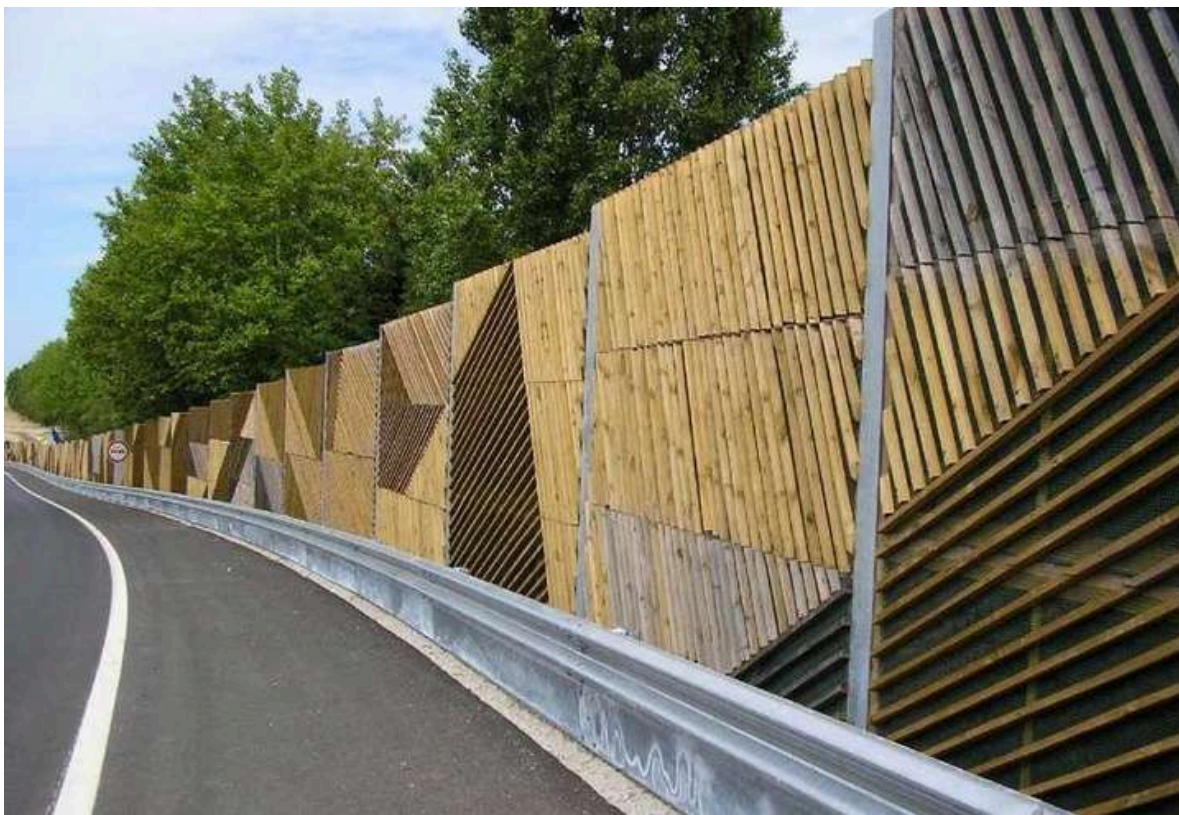
Figura 5. Barreira acústica em madeira, com lã de rocha no interior
